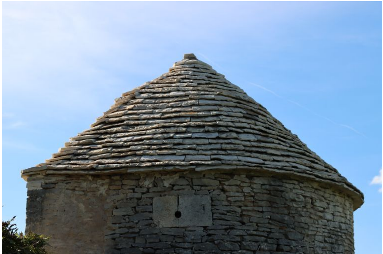
Détail de la toiture en lave et de l'ouverture de tir.
