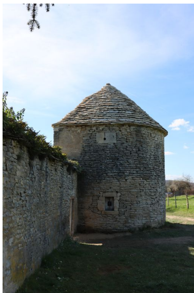
Vue de la tour depuis l'est, après restauration de la toiture en laves. Phot. Baptiste Quost IVR26_20242100055NUC2A
