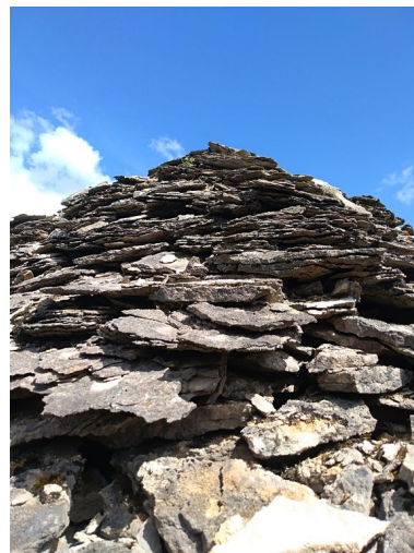
Détail de la toiture en laves, avant restauration. Phot. Baptiste Quost IVR26_20242100035NUC2A
