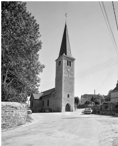
Eglise paroissiale Saint-Roch. Phot. Yves Sancey IVR43_19843900037V
