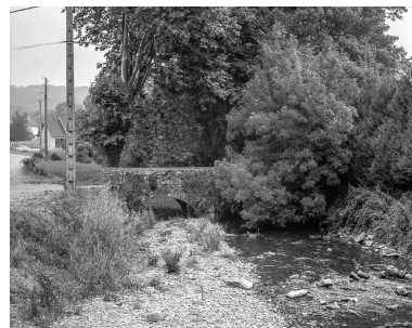
Pont sur la Sorne situé rue du Goujon. Phot. Yves Sancey IVR43_19843900056X
