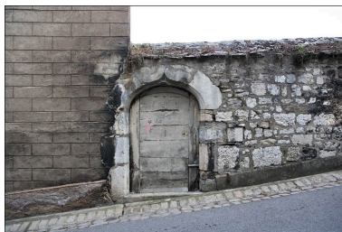
Détail de la porte dans la clôture de jardin. Phot. Yves Sancey IVR43_20102500437NUC2A
