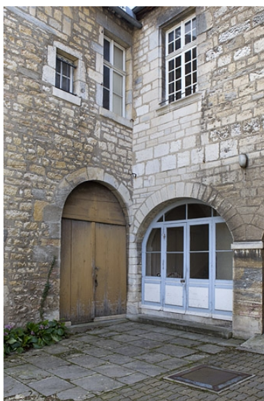
Détail de l'angle gauche entre l'aile gauche et le logis en fond de cour. Phot. Yves Sancey IVR43_20102500435NUC2A
