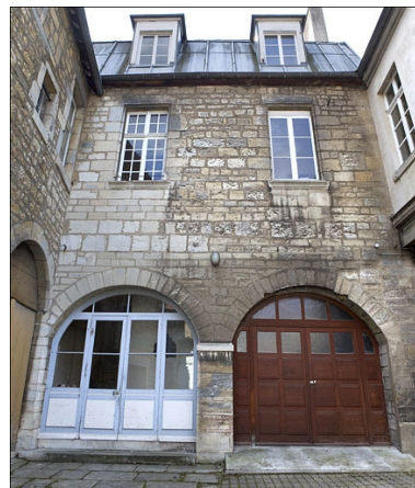
Vue d'ensemble de la façade antérieure du logis en fond de cour. Phot. Yves Sancey IVR43_20102500436NUC2A
