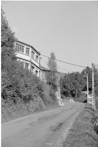
Façade latérale gauche. Phot. Laurent Poupard IVR43_19913901121Z
