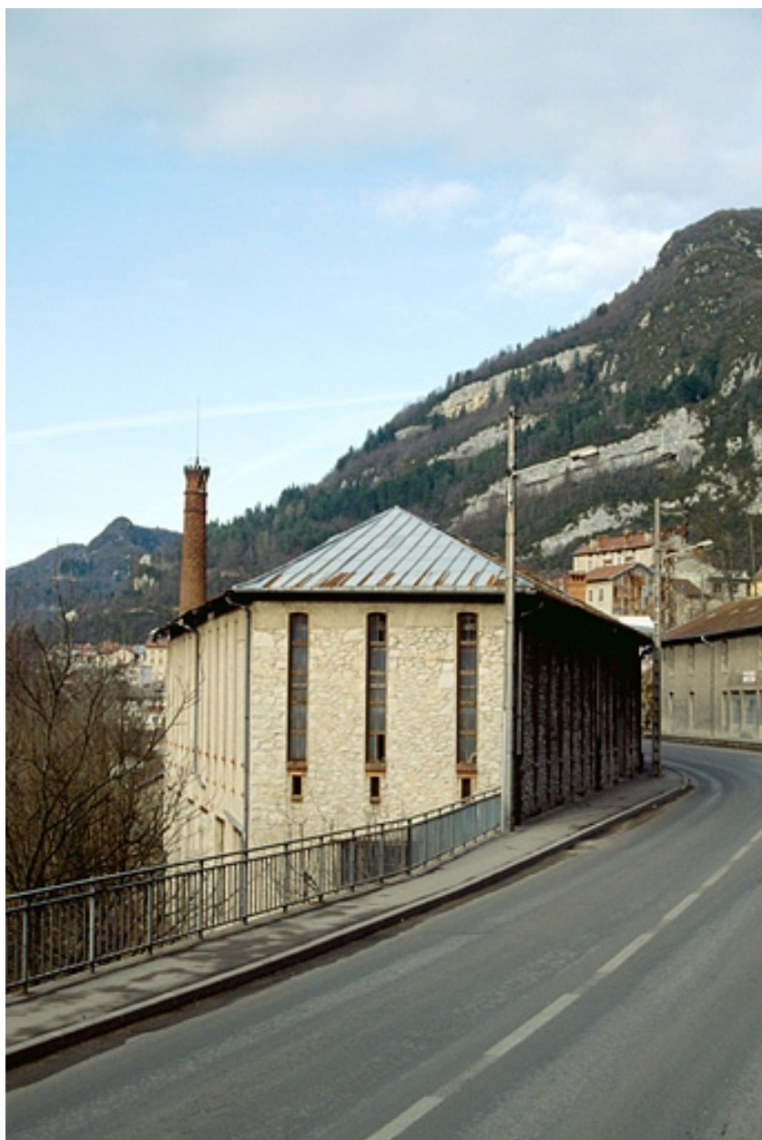
Façade latérale gauche du séchoir à ébauchons.
