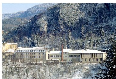
Vue d'ensemble depuis l'ouest. Phot. Laurent Poupard IVR43_19923901427ZA
