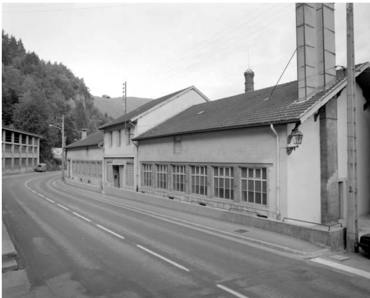
Façade antérieure des ateliers de fabrication.
