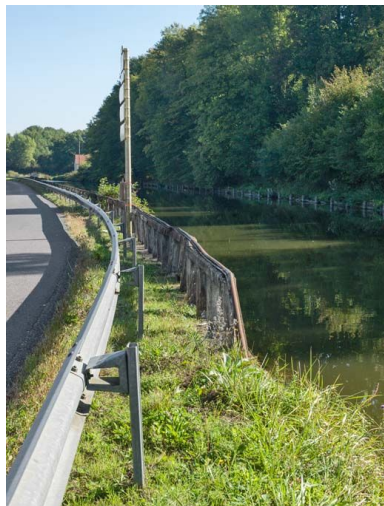
Vue du garde-corps métallique ancien.
