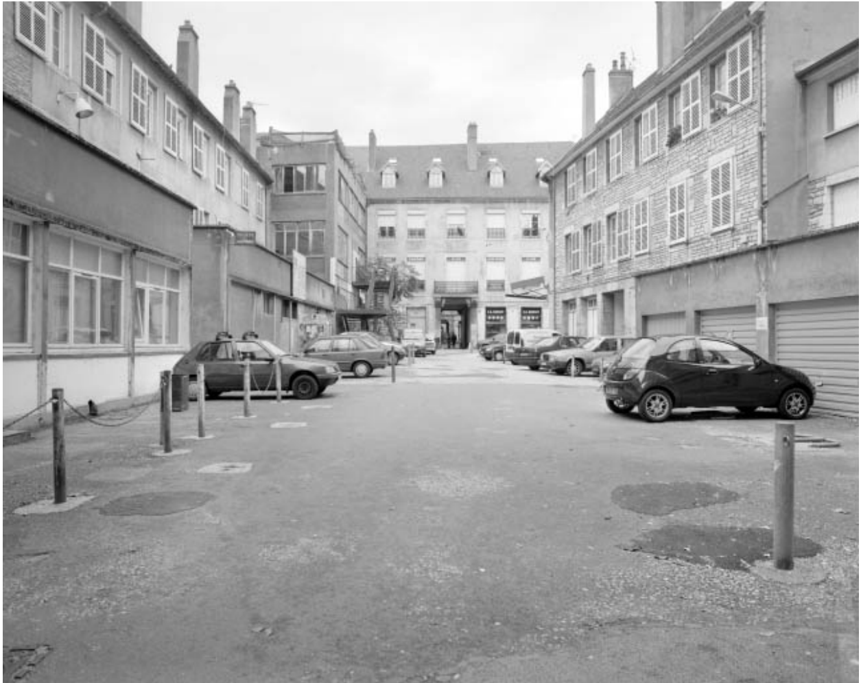
Vue d'ensemble de la deuxième cour.
