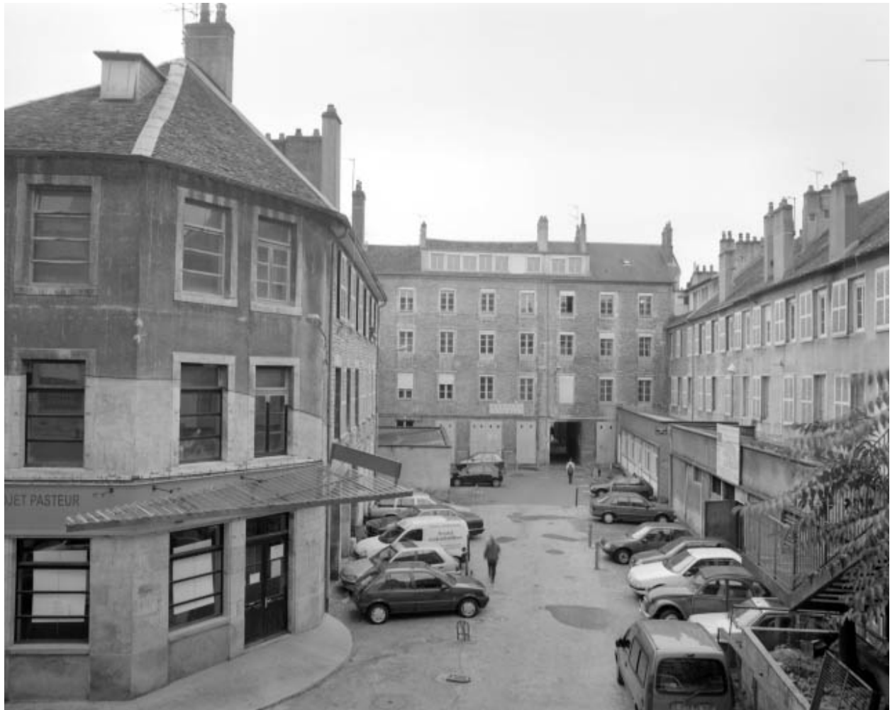
Vue d'ensemble des bâtiments bordant la deuxième cour.
