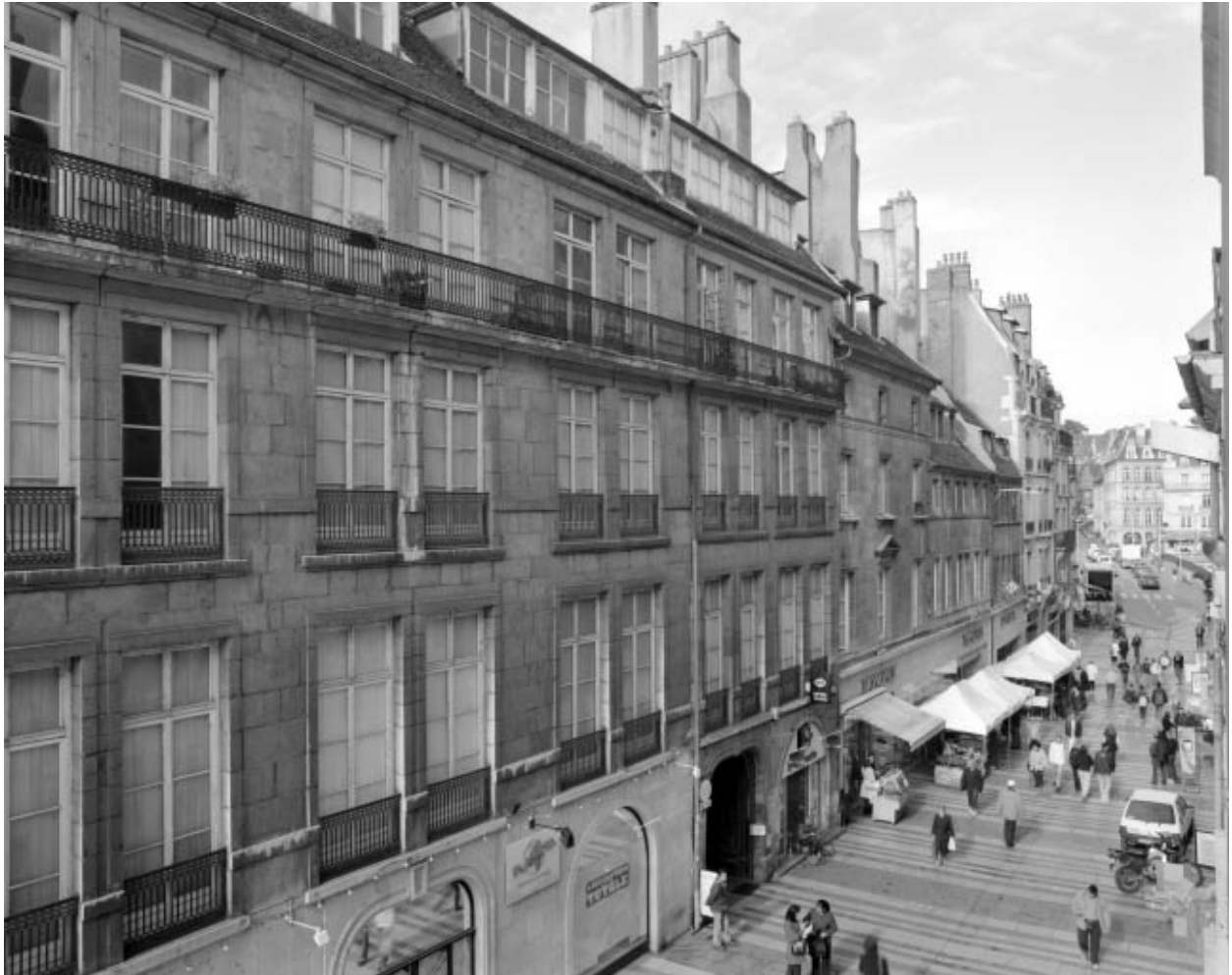
Façade sur rue, de trois quarts gauche.
