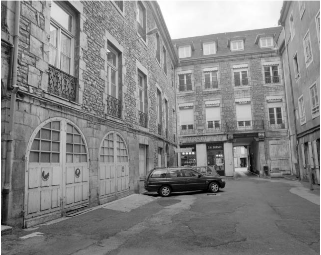
Détail de l'aile des remises, de trois quarts gauche.
