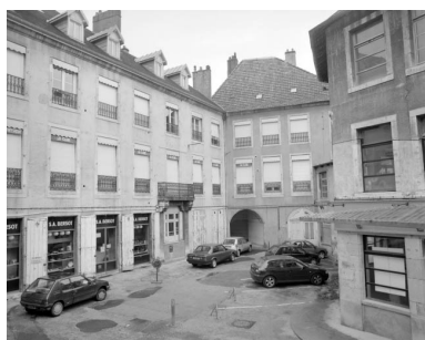
Façade postérieure du corps de logis sur cour, de trois quarts droit. Phot. Yves Sancey IVR43_20012500225X
