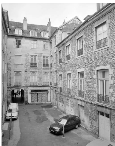
Vue de la première cour, depuis le logis sur cour : détail de l'aile des remises. Phot. Yves Sancey IVR43_20012500218X
