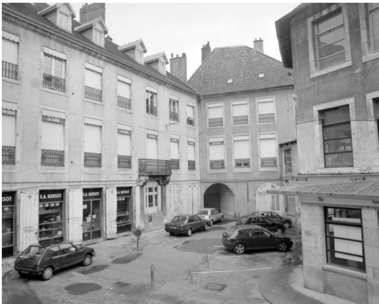
Façade postérieure du corps de logis sur cour, de trois quarts droit.
