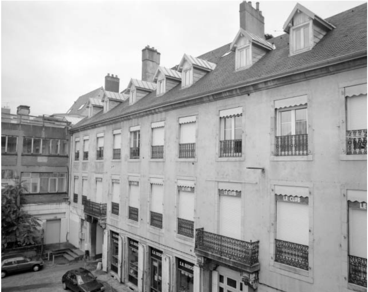
Façade postérieure du corps de logis sur cour, de trois quarts gauche.
