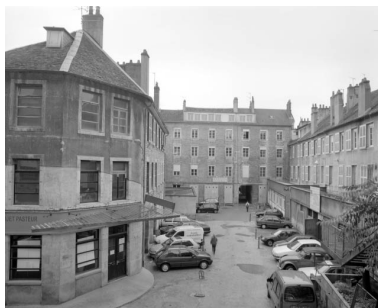
Vue d'ensemble des bâtiments bordant la deuxième cour. Phot. Yves Sancey IVR43_20012500284X
