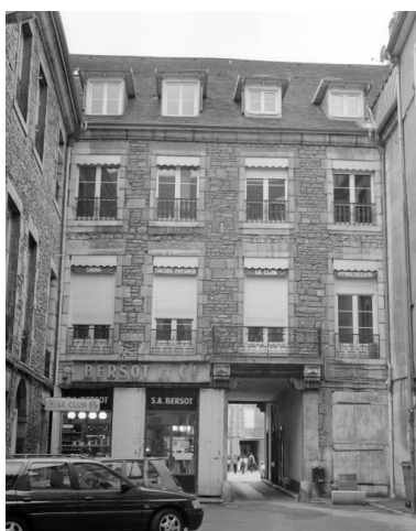
Façade antérieure du corps de logis sur cour : vue d'ensemble. Phot. Yves Sancey IVR43_20012500220X
