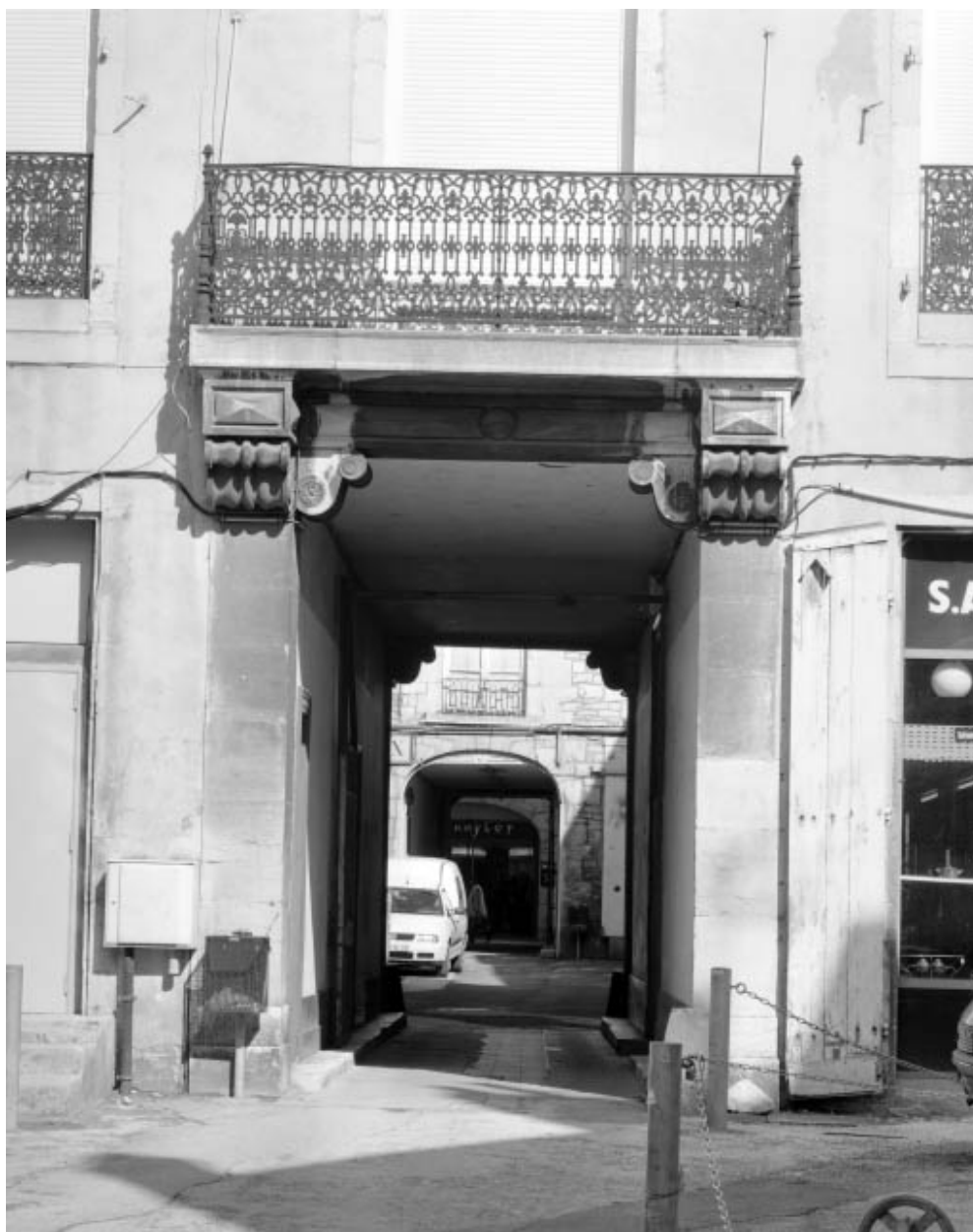
Façade postérieure du corps de logis sur cour, détail de l'entrée cochère.
