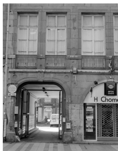
Façade sur rue, détail de l'entrée cochère. Phot. Yves Sancey IVR43_20012500216X
