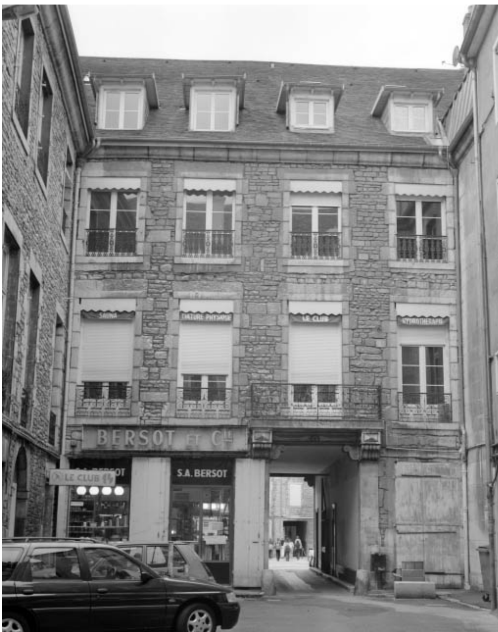
Façade antérieure du corps de logis sur cour : vue d'ensemble.
