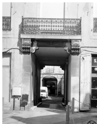
Façade postérieure du corps de logis sur cour, détail de l'entrée cochère. Phot. Yves Sancey IVR43_20012500226X
