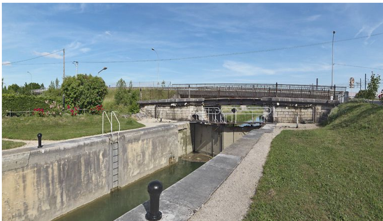
Le sas avec le pont vu d'amont.
