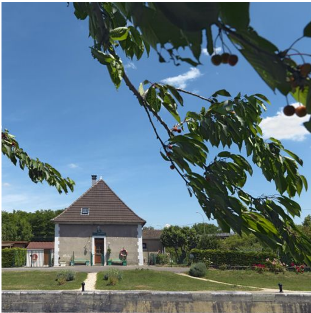
Façade de la maison éclusière : seule une porte ouvre sur le canal. Le modèle de cette série présentait une fenêtre de chaque côté de la porte.
