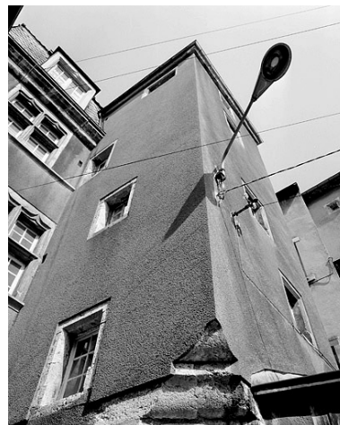
Tour d'escalier. Phot. Jérôme Mongreville IVR43_19872500807X
