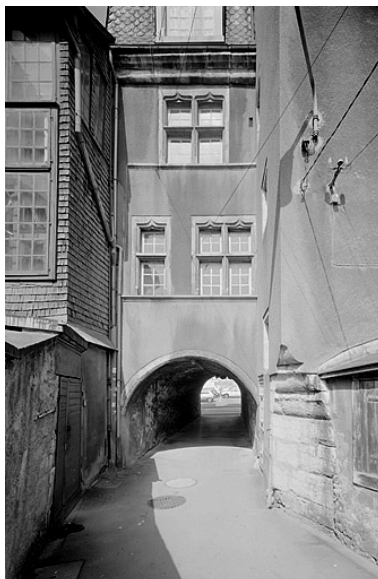
Façade sur le passage de la Fleur. Phot. Jérôme Mongreville IVR43_19872501081V
