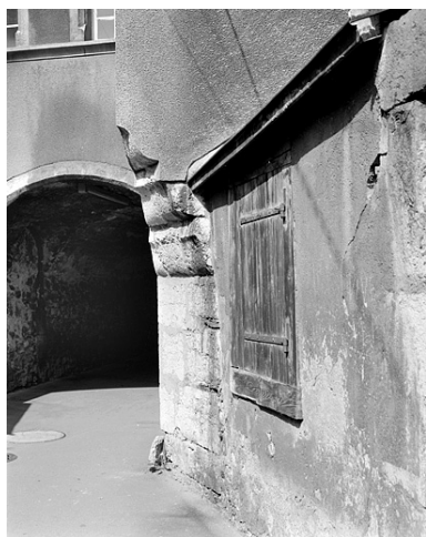
Surplomb de la tour d'escalier. Phot. Jérôme Mongreville IVR43_19872500808X
