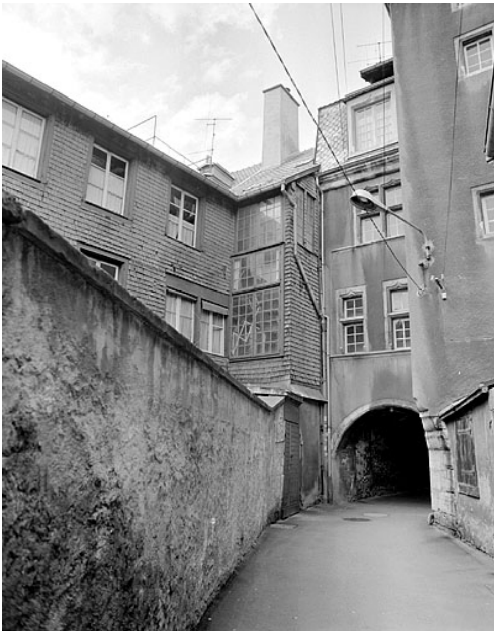
Galleries de distribution desservant l'aile en retour.
