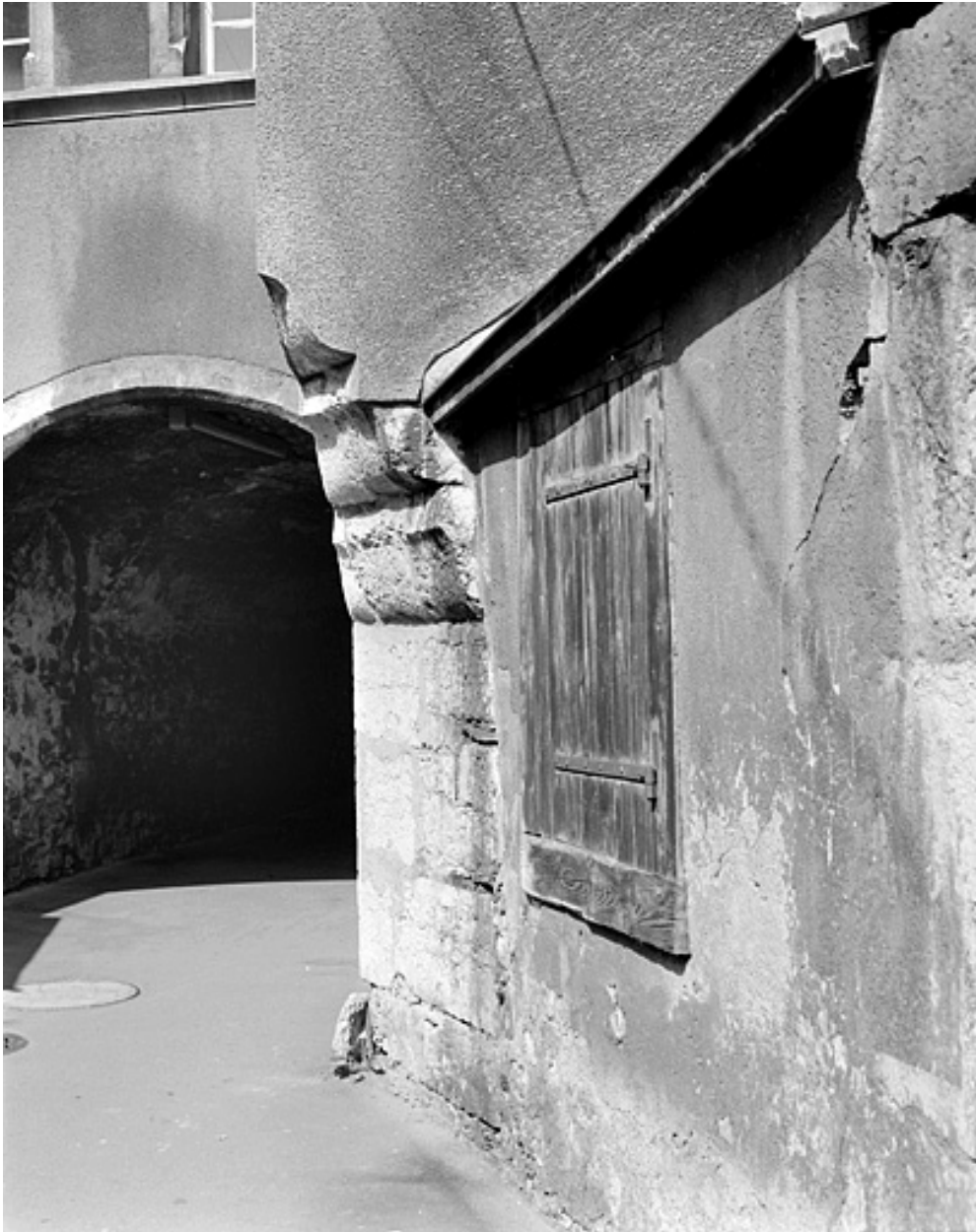
Surplomb de la tour d'escalier.
