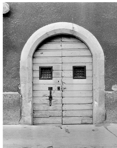
Façade sur rue. Porte de la cave haute. Phot. Jérôme Mongreville IVR43_19872500806X
