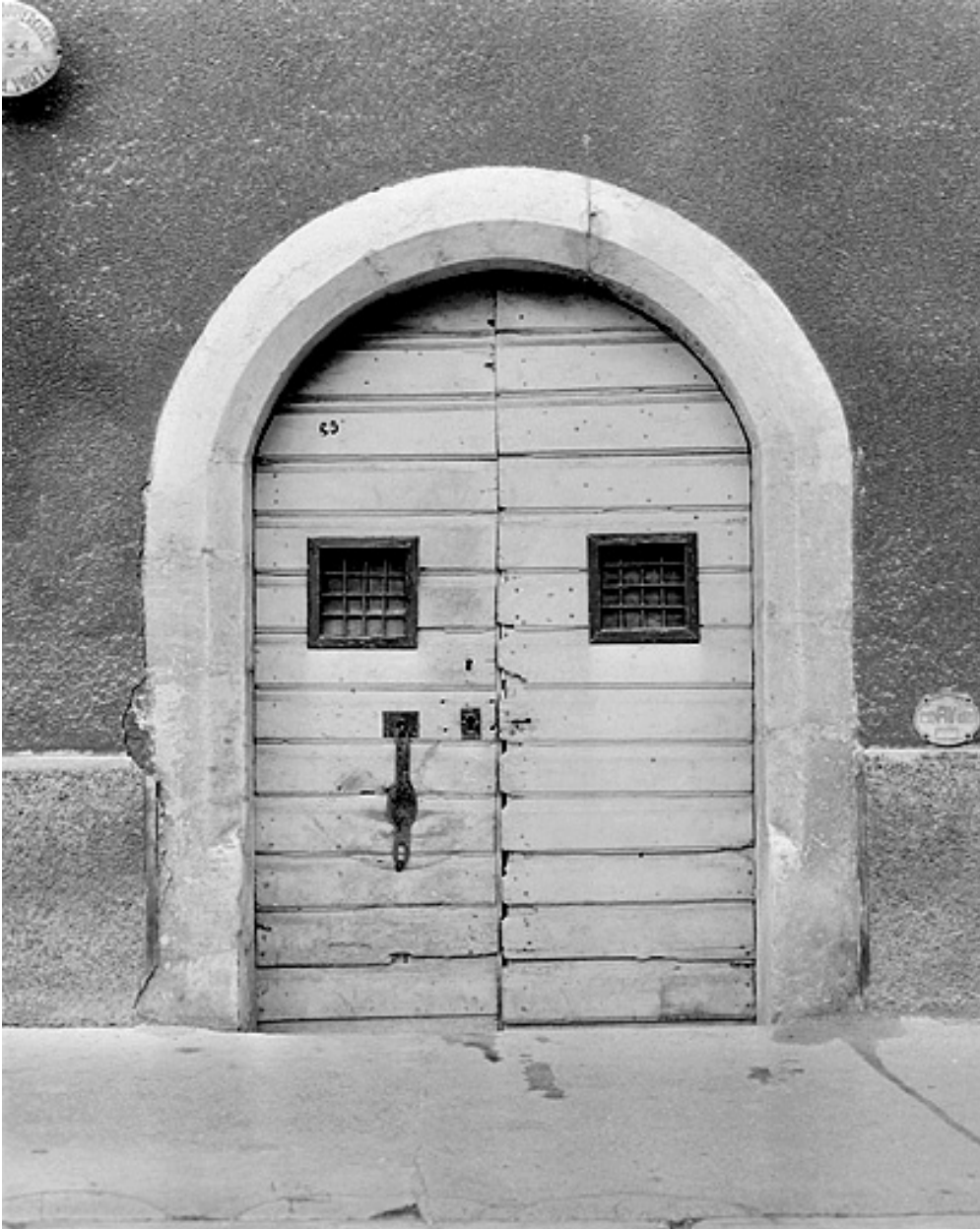
Façade sur rue. Porte de la cave haute.
