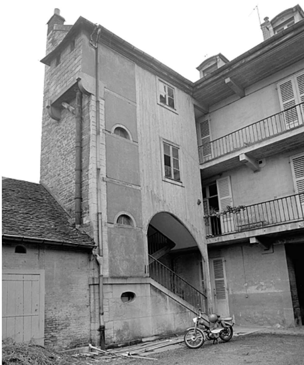
Escalier dans la cour.
