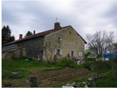
Vue générale du pignon nord- est et de la façade postérieure. Phot. Marie-Pierre Reynet IVR43_20083900432NUC1A
