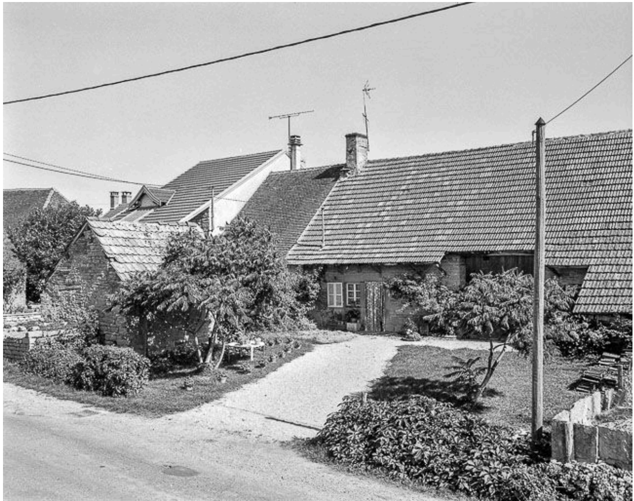
Ferme située rue du Centre : façade antérieure.
