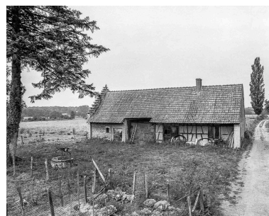
Ferme située aux Piés : façade antérieure. Phot. Yves Sancey IVR43_19843900033X
