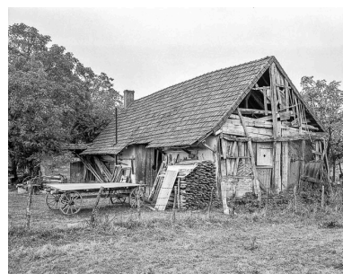
Ferme située chemin des Golards : façade antérieure et face droite. Phot. Yves Sancey IVR43_19843900027X
