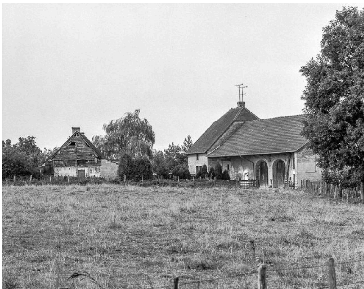
Ferme située chemin des Golards : vue d'ensemble.
