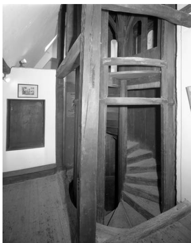
Détail du cylindre pivotant ouvert, au niveau de la cellule de saint Pierre Fourier.
