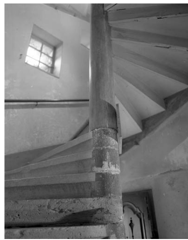
Tour Saint Pierre Fourier : détail de l'escalier en vis, en pierre puis en bois donnant accès à l'escalier pivotant. Phot. Yves Sancey IVR43_19917000187X
