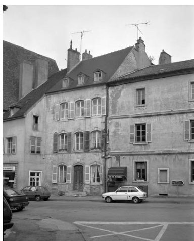
Façade antérieure du 8 rue du Marché. Phot. Yves Sancey IVR43_19917000180X
