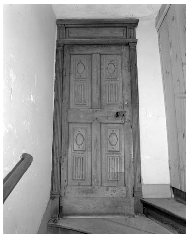
Porte d'entrée masquant l'escalier pivotant en bois.
