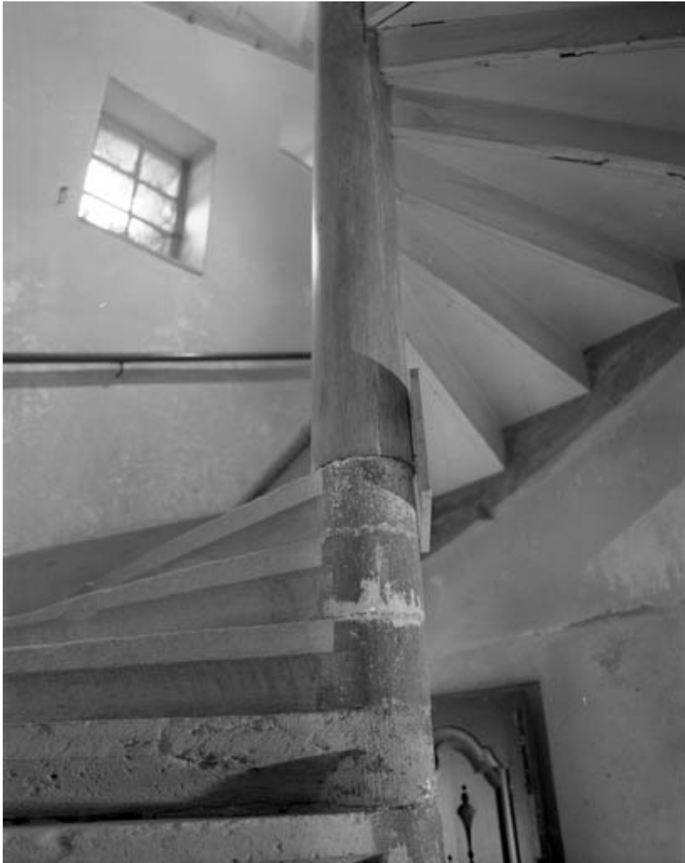
Tour Saint Pierre Fourier : détail de l'escalier en vis, en pierre puis en bois donnant accès à l'escalier pivotant.
