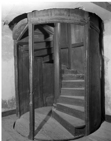
Détail du rez-de-chaussée du cylindre pivotant contenant l'escalier : partie libre donnant accès à l'escalier.
