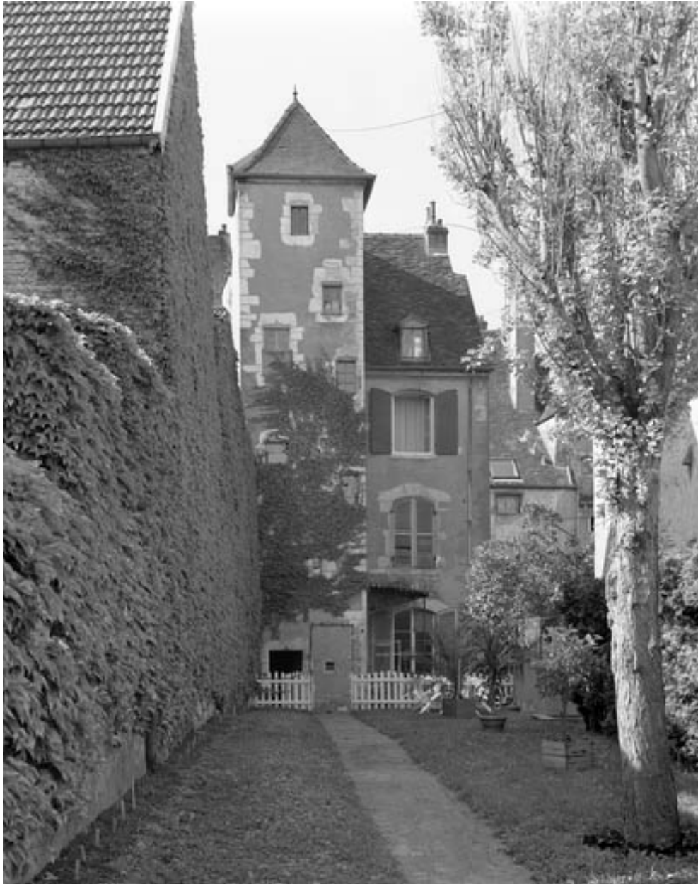
Façade postérieure du n° 8 de la rue du Marché, avec la tour Saint Pierre Fourier : vue rapprochée.
