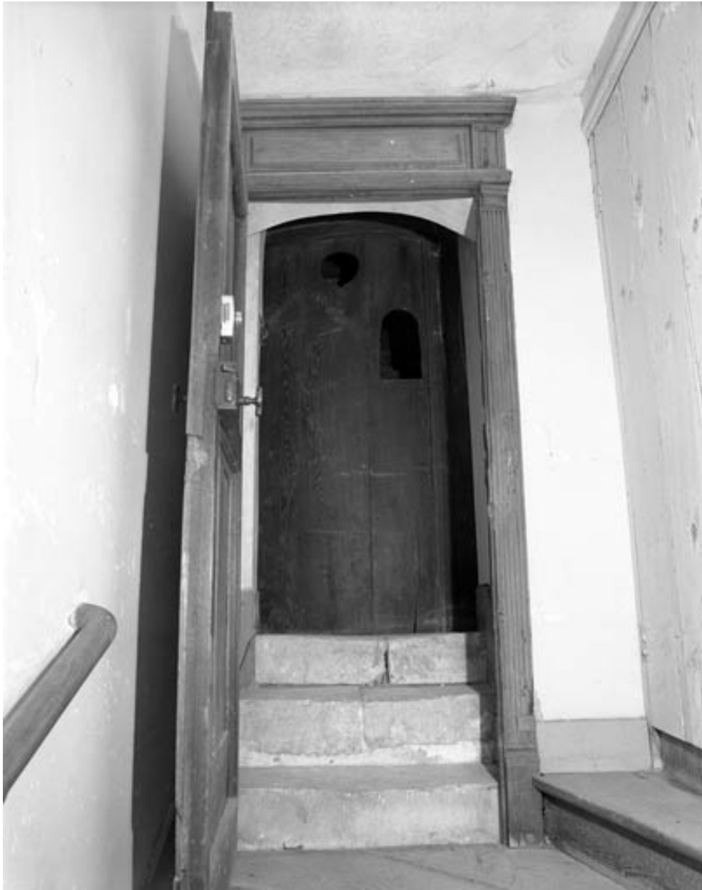
Porte d'entrée ouverte montrant le cylindre pivotant fermé contenant l'escalier.
