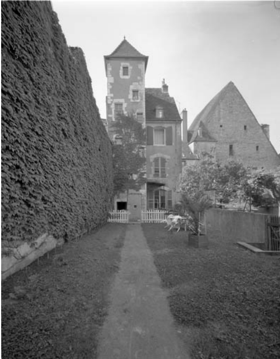
Façade postérieure du n° 8 de la rue du Marché, avec la tour Saint Pierre Fourier, et la façade postérieure du grenier à blé.
