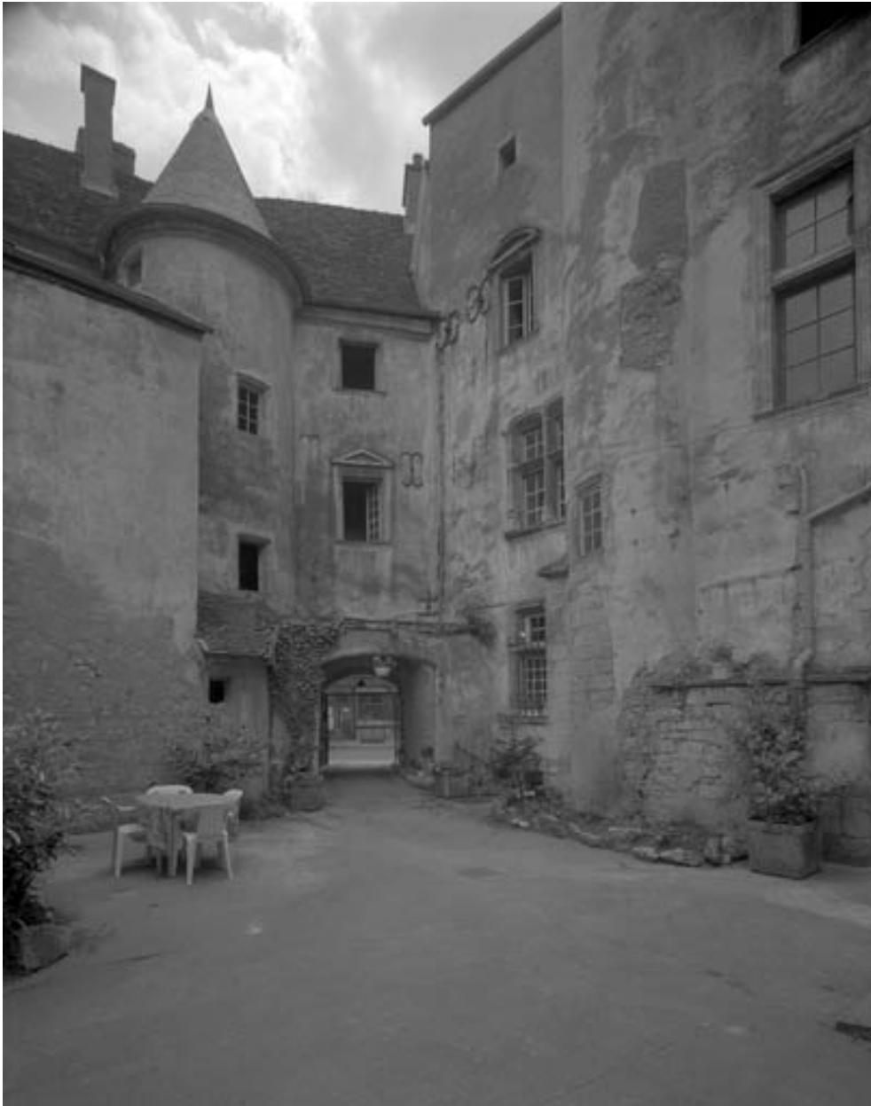
Bâtiment droit : vue du passage couvert depuis le fond de la cour intérieure.
