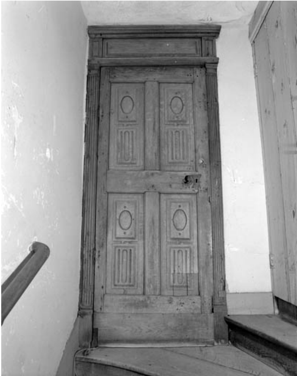
Porte d'entrée masquant l'escalier pivotant en bois.
