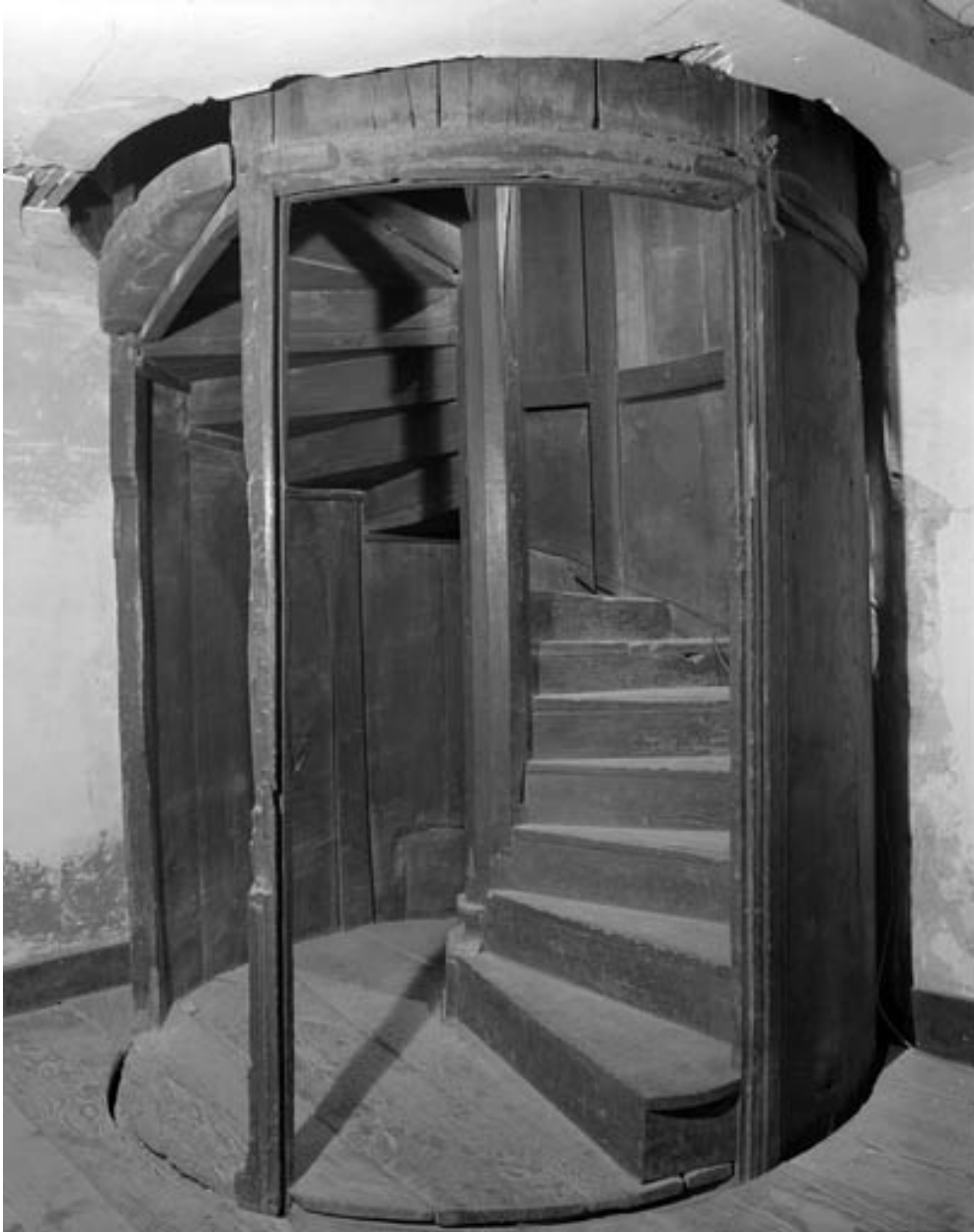
Détail du rez-de-chaussée du cylindre pivotant contenant l'escalier : partie libre donnant accès à l'escalier.
