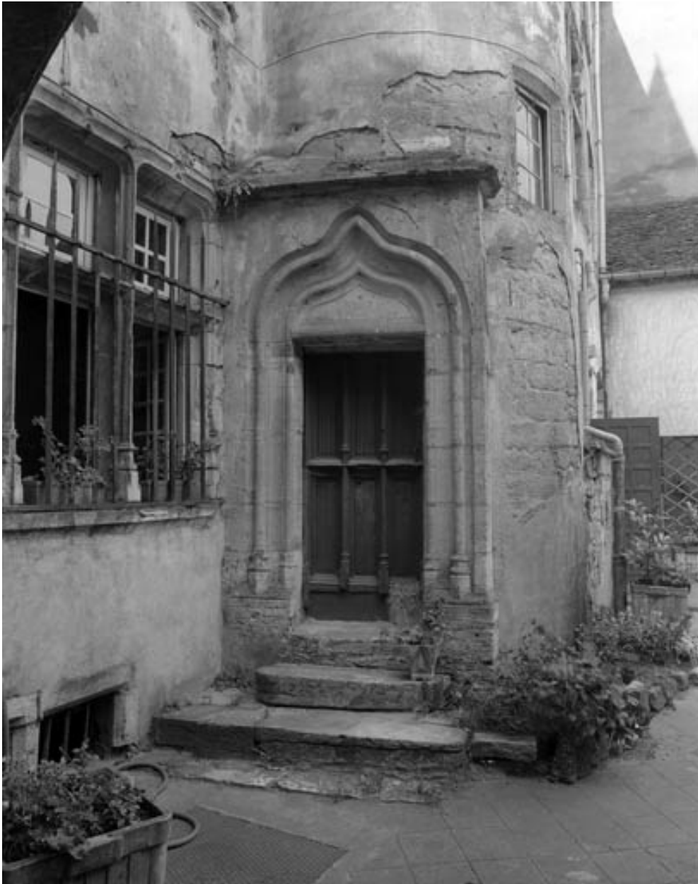
Façade sur cour : partie droite, détail de la porte de l'escalier en vis.
