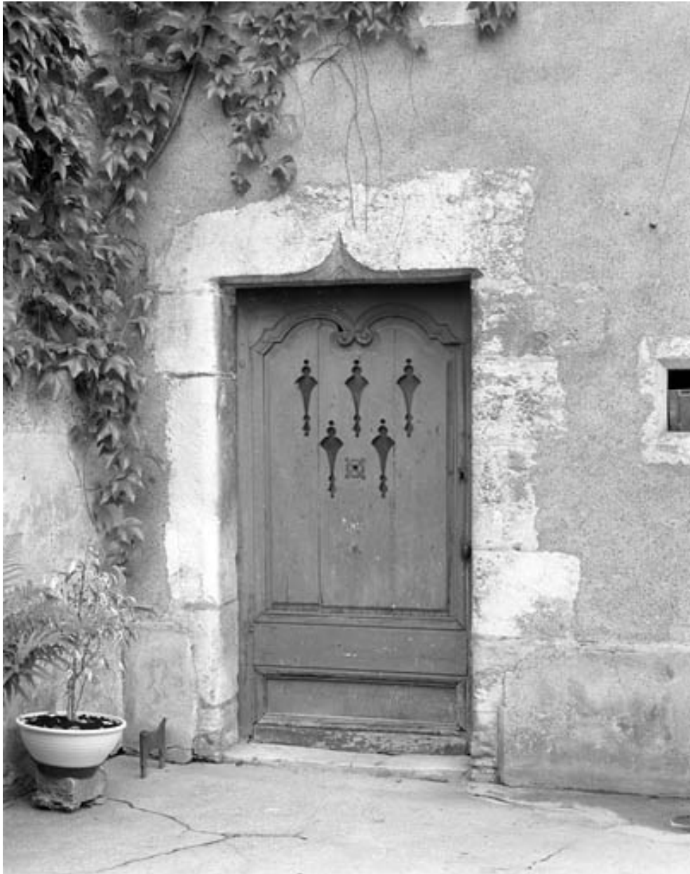
Tour Saint Pierre Fourier : détail de la porte d'entrée sur cour.
