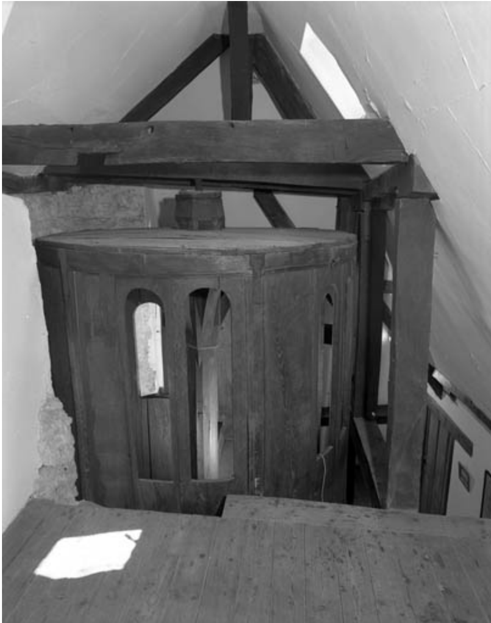
Sommet du cylindre depuis les combles.
