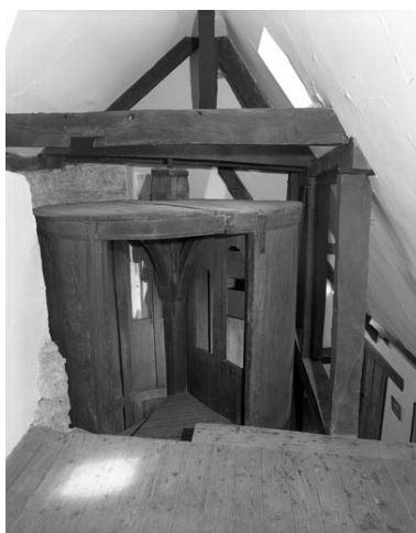
Sommet du cylindre depuis les combles avec le détail de la partie supérieure du noyau de l'escalier. Phot. Yves Sancey IVR43_19917000198X
