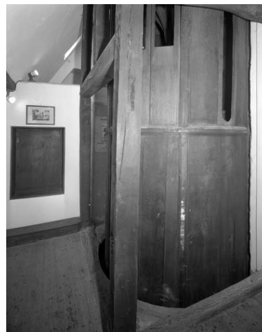
Détail du cylindre pivotant fermé, au niveau de la cellule de saint Pierre Fourier.
