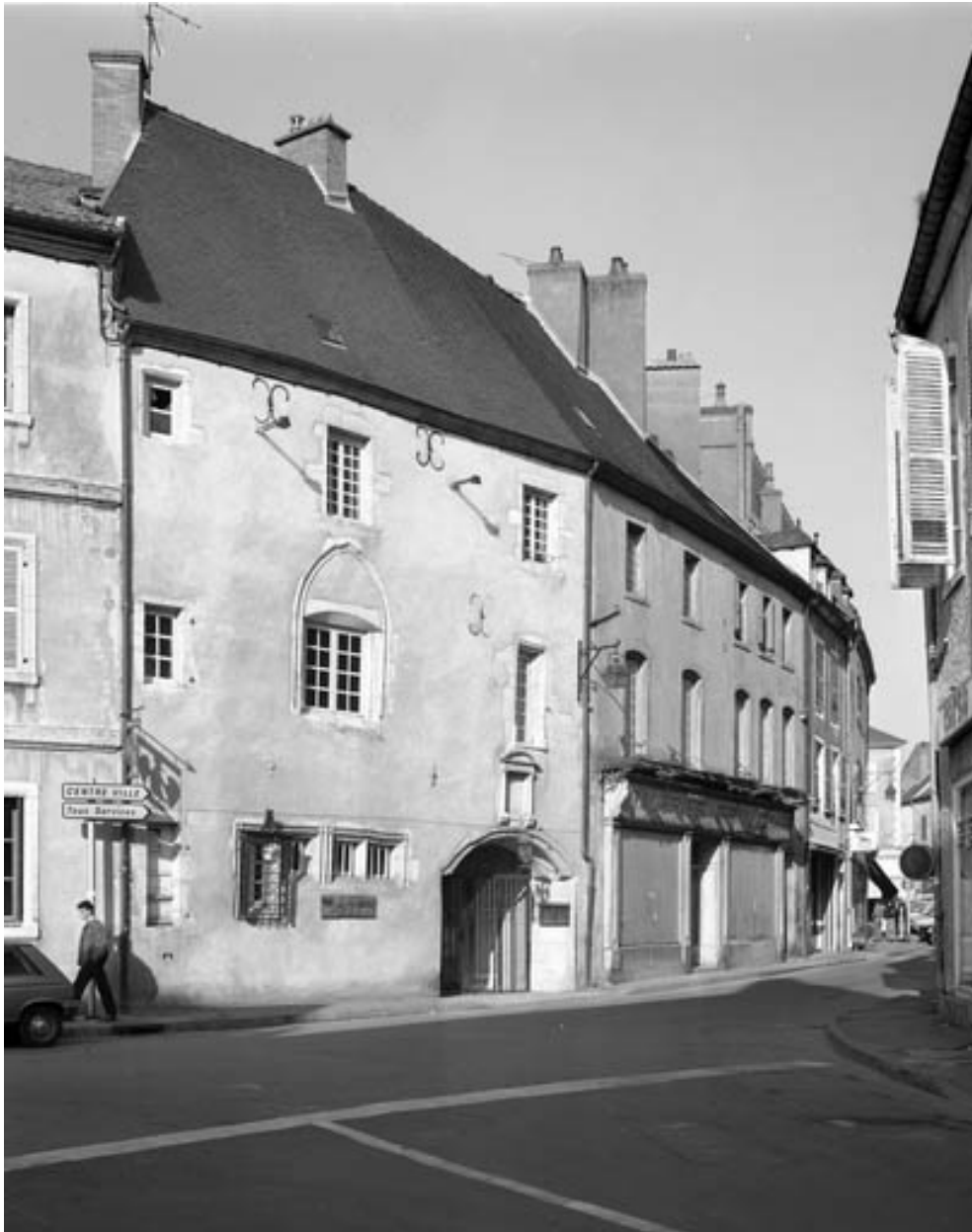
Façade antérieure : partie droite, vue rapprochée.
