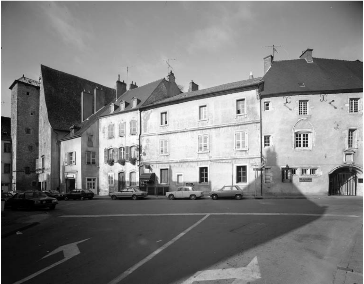
Vue d'ensemble des façades antérieures constituant l'ancien hôtel Gauthiot d'Ancier.
