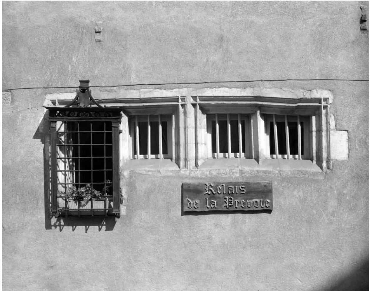
Façade antérieure : partie droite, détail d'une baie du rez de chaussée.
