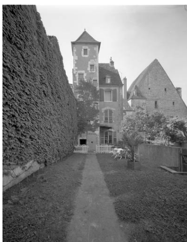
Façade postérieure du n° 8 de la rue du Marché, avec la tour Saint Pierre Fourier, et la façade postérieure du grenier à blé. Phot. Yves Sancey IVR43_19917000183V
