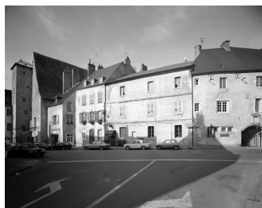
Vue d'ensemble des façades antérieures constituant l'ancien hôtel Gauthiot d'Ancier. Phot. Yves Sancey IVR43_19897000218V
