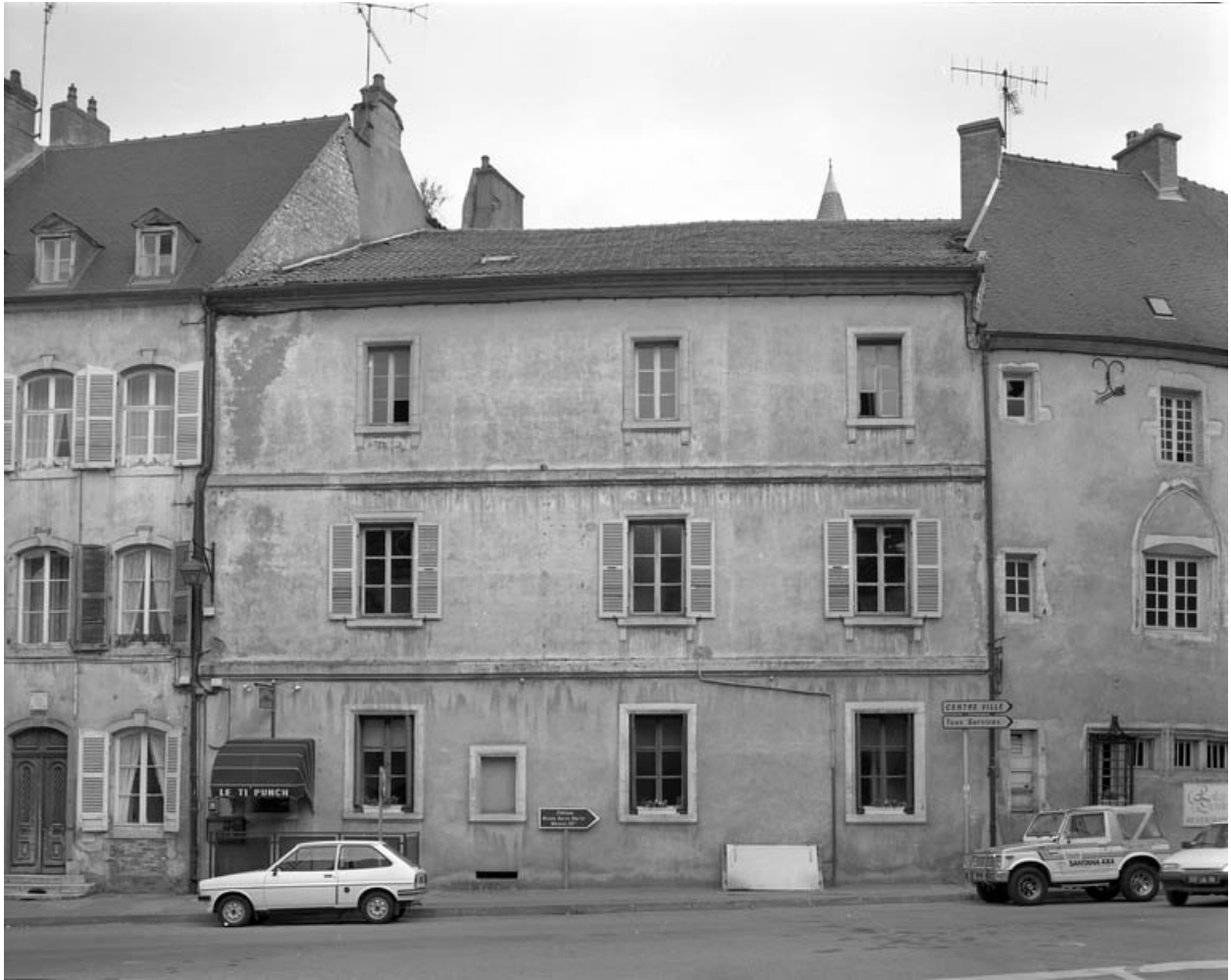
Bâtiment central : façade antérieure, de face.
