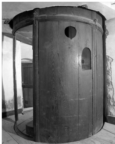
Détail du rez-de-chaussée du cylindre pivotant contenant l'escalier : partie pleine.
