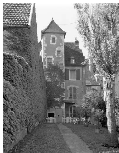
Façade postérieure du n° 8 de la rue du Marché, avec la tour Saint Pierre Fourier : vue rapprochée. Phot. Yves Sancey IVR43_19917000184V
