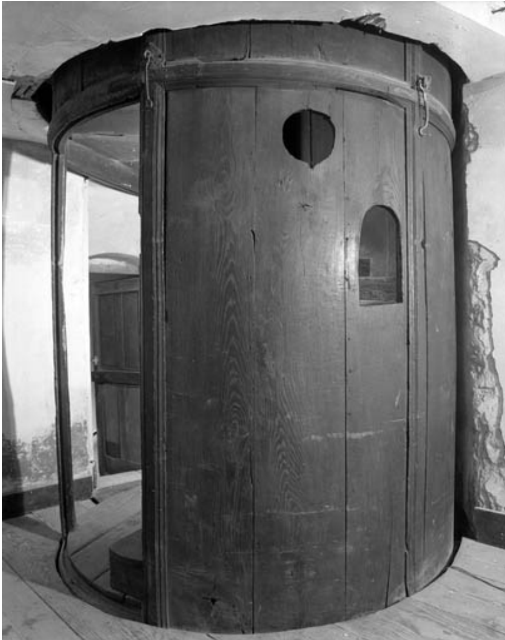
Détail du rez-de-chaussée du cylindre pivotant contenant l'escalier : partie pleine.
