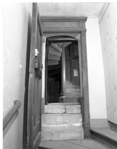
Tour Saint Pierre Fourier : détail de l'escalier en vis, en pierre puis en bois donnant accès à l'escalier pivotant. Phot. Yves Sancey IVR43_19917000187X
