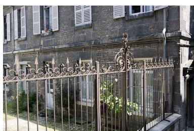
Vue de la grille séparant les deux cours, de trois quarts gauche. Phot. Yves Sancey IVR43_20082500490NUC2A
