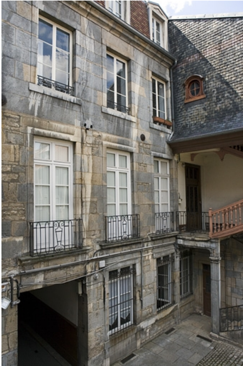
Vue de la façade postérieure du logis principal de trois quarts gauche.
