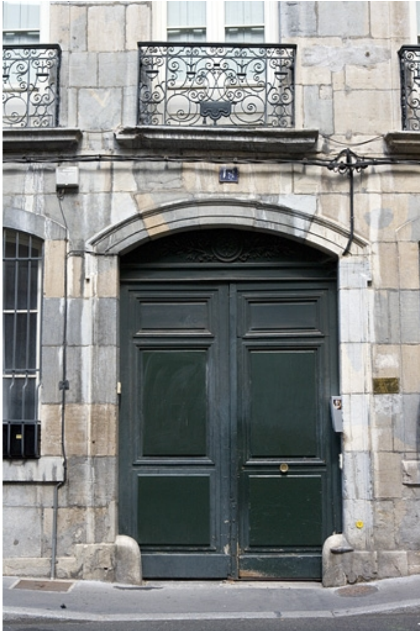
Logis principal : détail du portail d'entrée.
