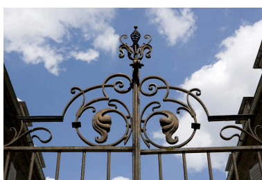
Détail de la partie supérieure de la grille séparant les deux cours. Phot. Yves Sancey IVR43_20082500491NUC2A
