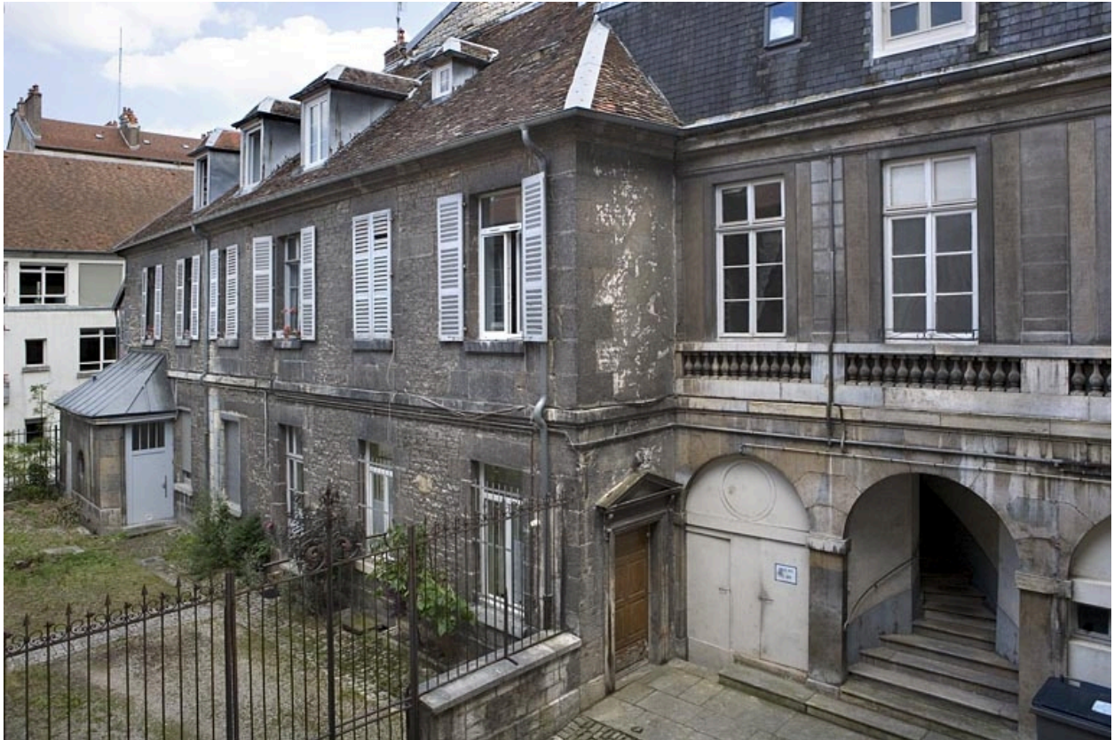
Vue des ailes droites de la première et de la deuxième cours : de trois quarts.
