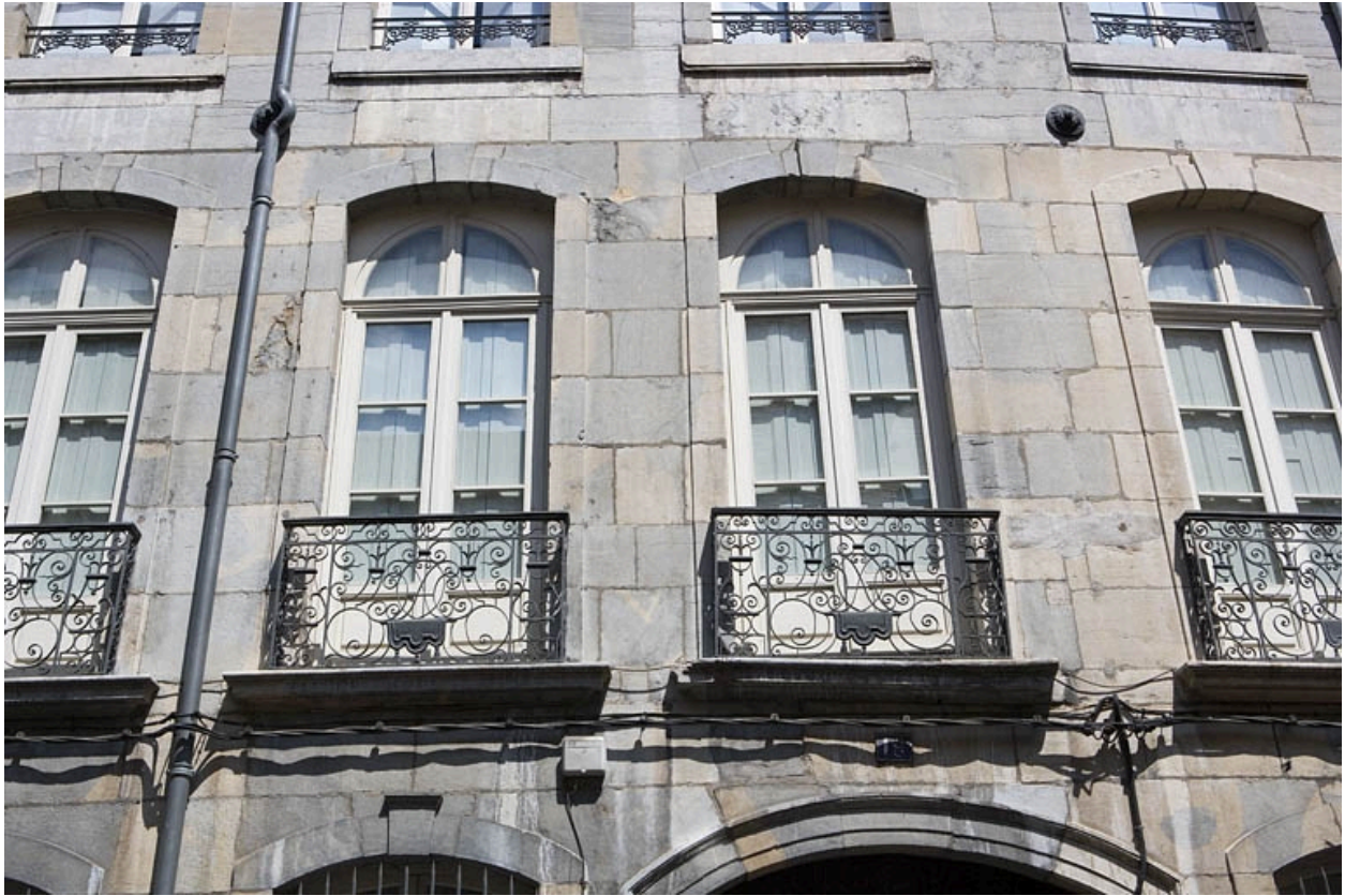
Logis principal : détail des garde-corps des fenêtres du premier étage sur rue.
