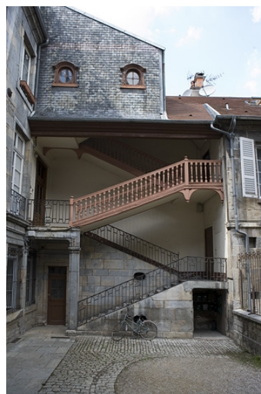
Vue de l'escalier à cage ouverte à gauche de la cour. Phot. Yves Sancey IVR43_20082500484NUC2A
