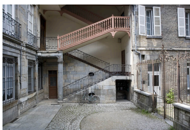
Vue de l'escalier à cage ouverte à gauche de la cour : de face. Phot. Yves Sancey IVR43_20082500485NUC2A
