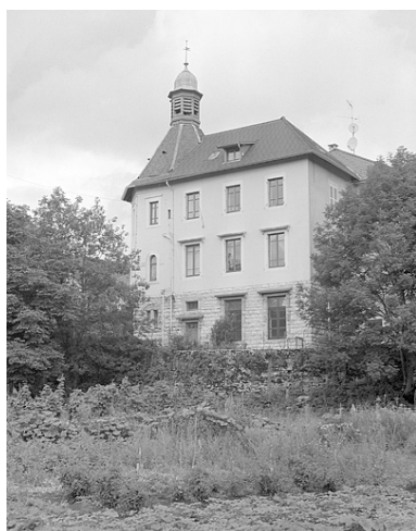
Face sud. Phot. Jérôme Mongreville IVR43_19963901170X
