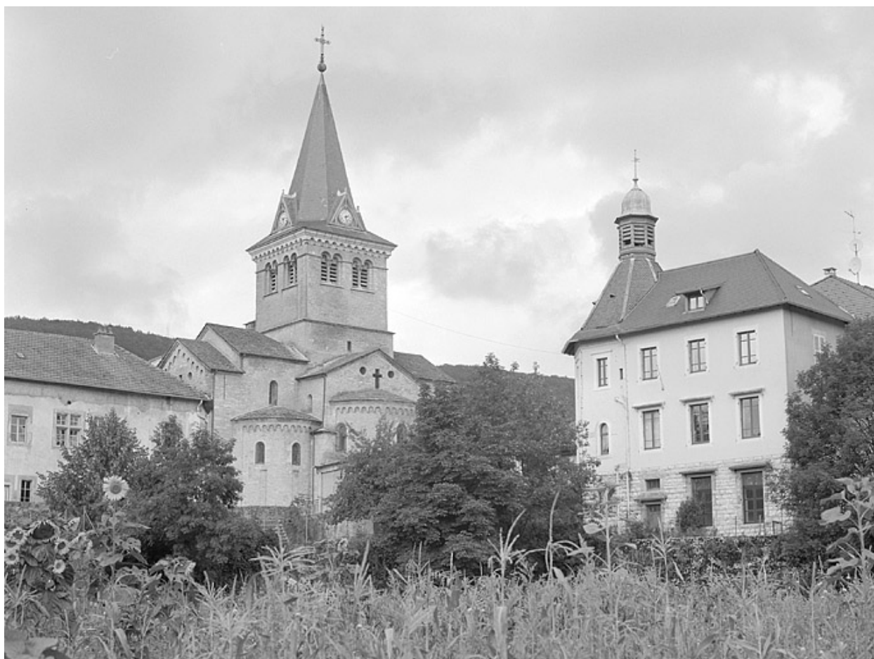
L'église paroissiale et l'ancienne mairie.
