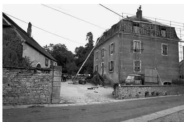
Maison située rue de l'Eglise. Phot. Bernard Lardière IVR43_19797000195Z
