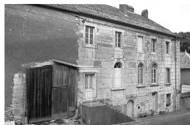
Maison située rue de l'Eglise. Phot. Bernard Lardière IVR43_19797000201Z
