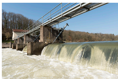
La passerelle du barrage. Phot. Sonia Dourlot IVR43_20167000275NUC4A
