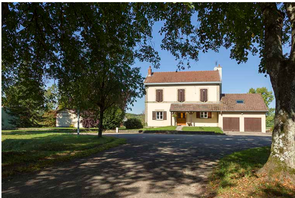
Façade sud-est de l'ancienne gare.
