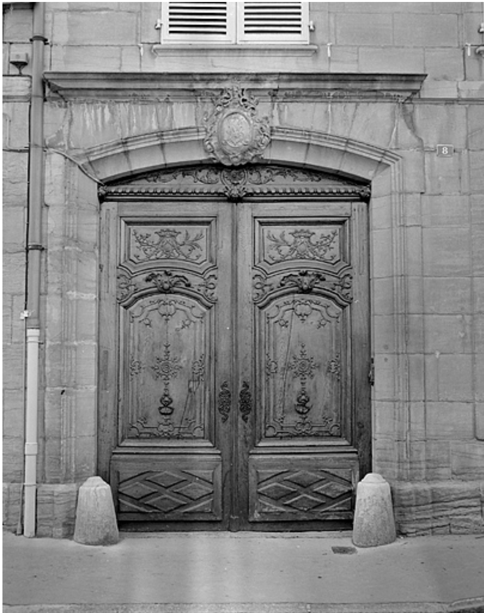
Portail de la façade antérieure.
