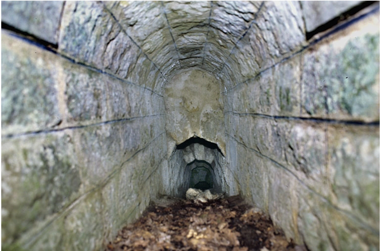
Voûte appareillée en rouleaux à ressauts, depuis l'amont.
