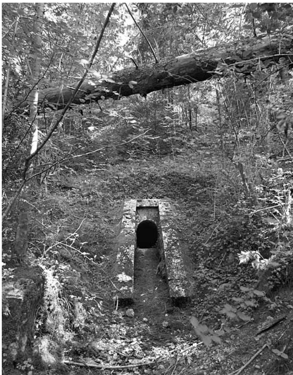
Vue d'ensemble de la tête aval (ouest).
