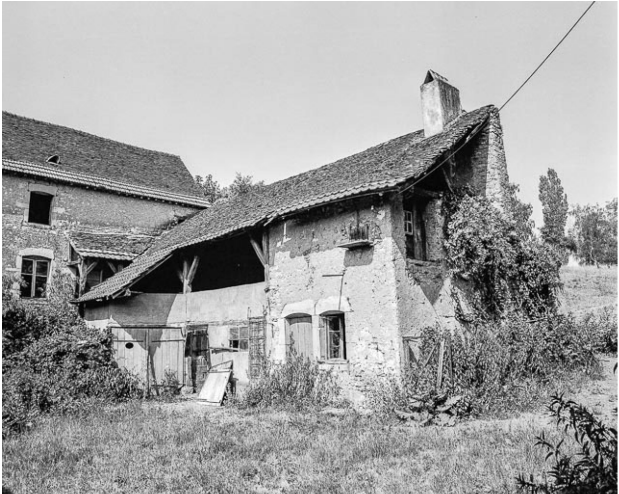
Façade antérieure et aile droite.
