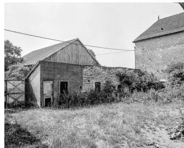
Dépendances à gauche, le long de la rue. Phot. Dominique Humbert IVR43_19767000492X
