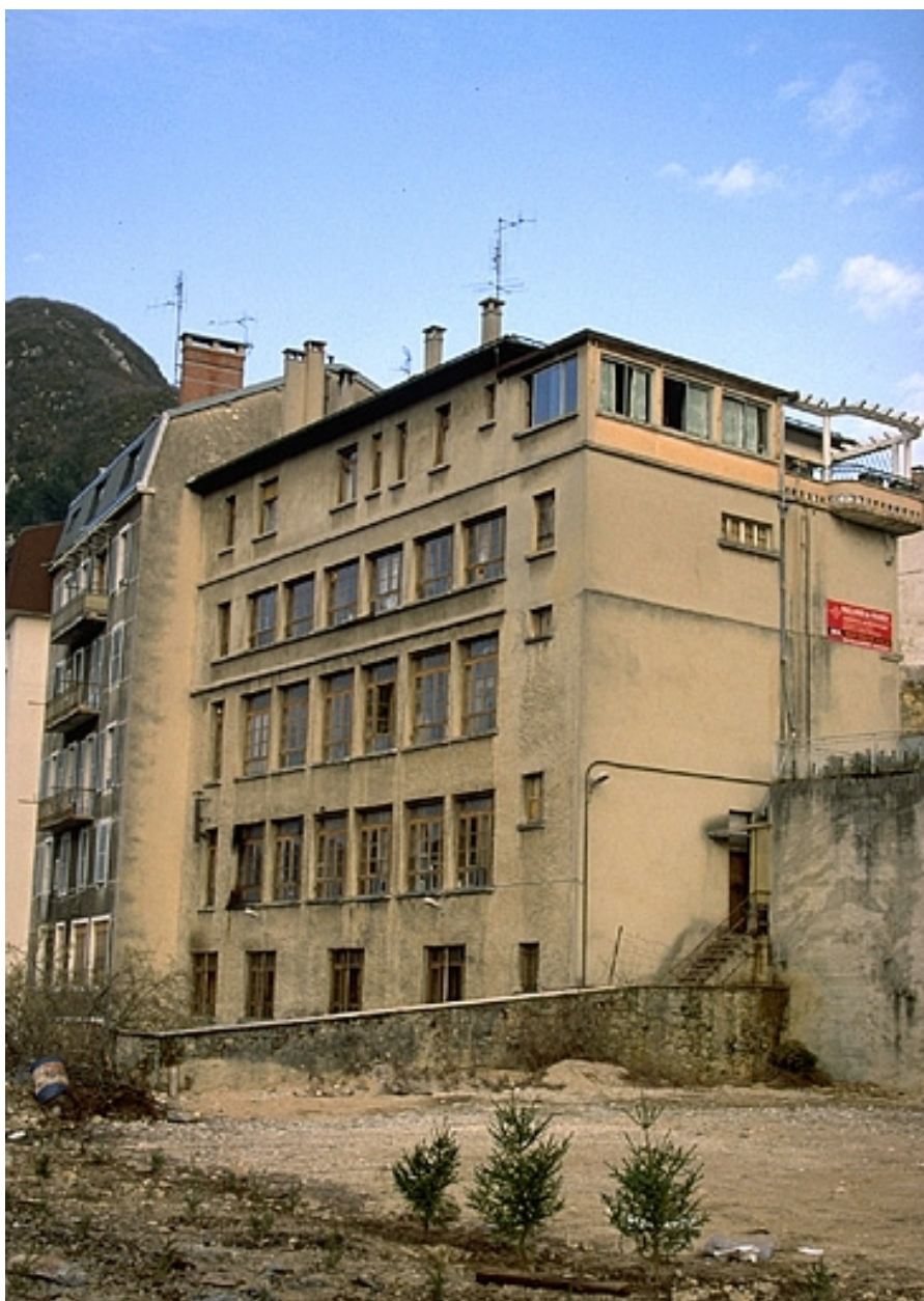
Façades postérieure et latérale gauche.
