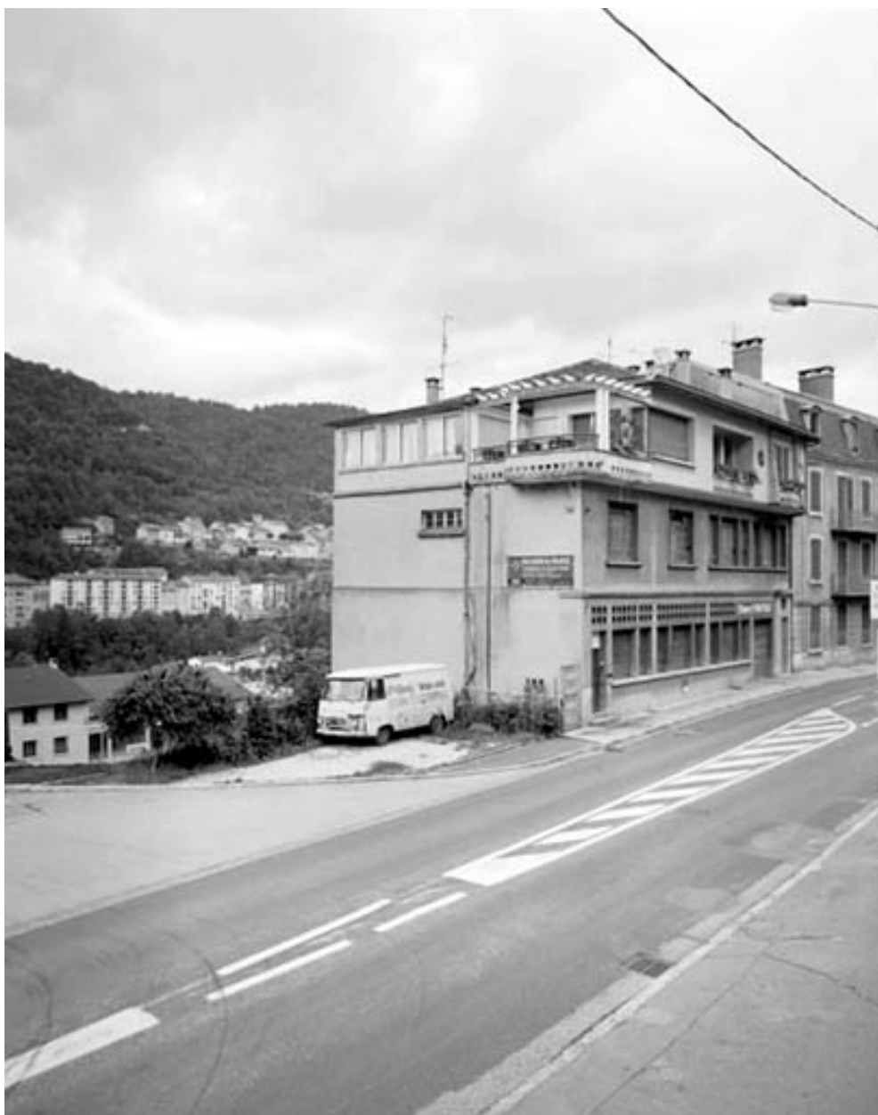
Façades antérieure et latérale gauche.
