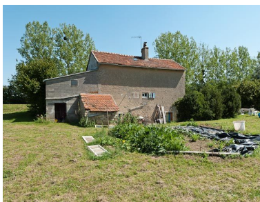
Vue arrière de la maison éclusière. Phot. Pierre-Marie Barbe-Richaud IVR26_20112103923NUC4AQ
