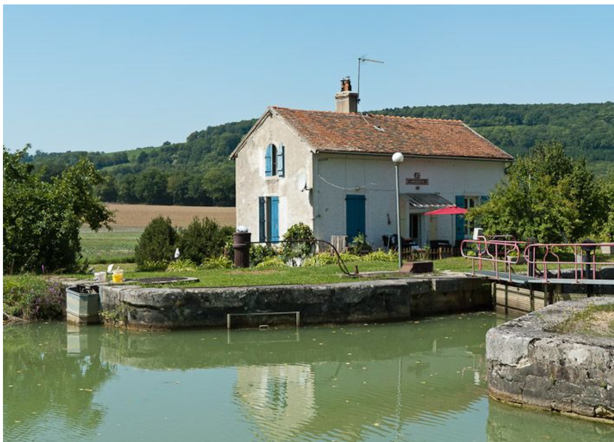
Vue du site d'écluse depuis l'amont.
