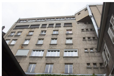
Façade postérieure : vue rapprochée.
