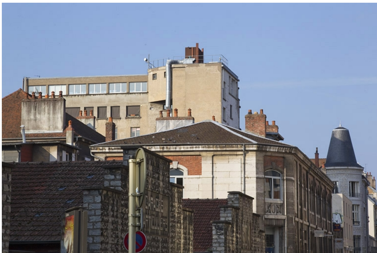
Façade postérieure : vue éloignée.
