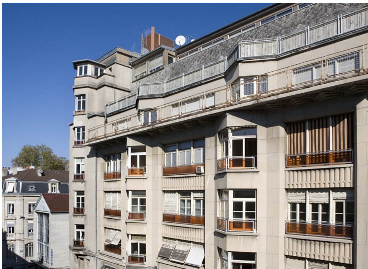
Façade antérieure : détail des étages supérieurs.
