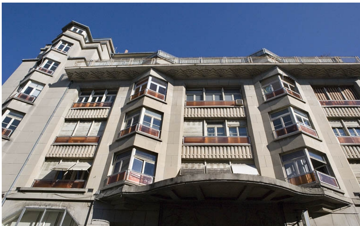
Façade : auvent et balcons.
