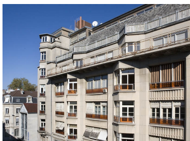
Façade antérieure : détail des étages supérieurs. Phot. Yves Sancey IVR43_20062500627NUCA
