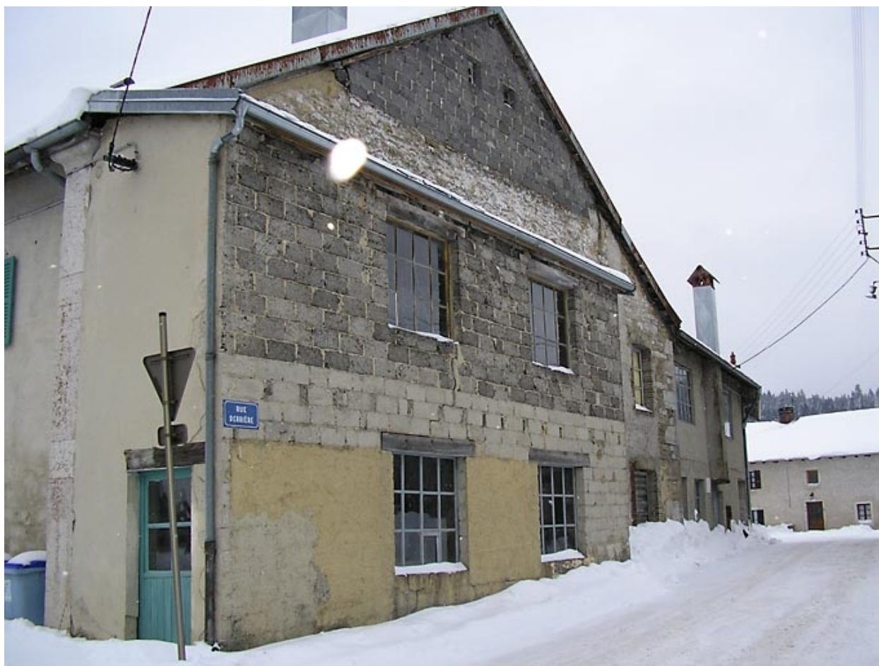
Façade latérale vue de trois quarts.
