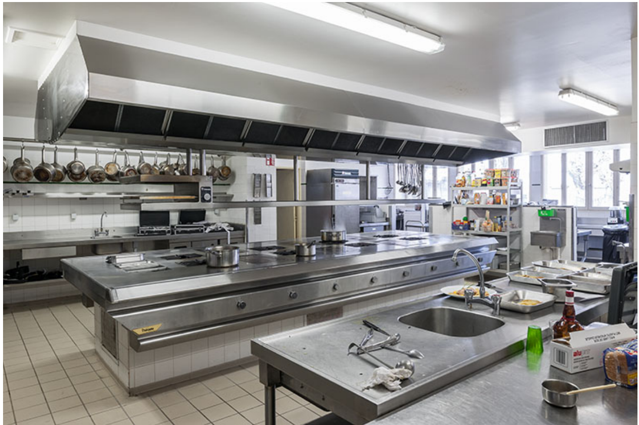
Restaurant d'application : les cuisines.
