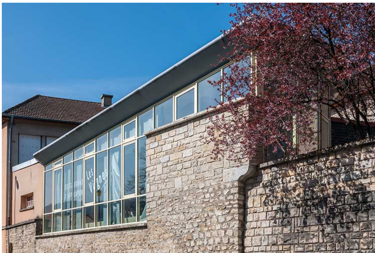
Restaurant d'application : façade sur avenue Delort
