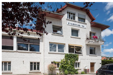
Façade antérieure de la maison. Phot. Sonia Dourlot IVR43_20162501691NUC4A
