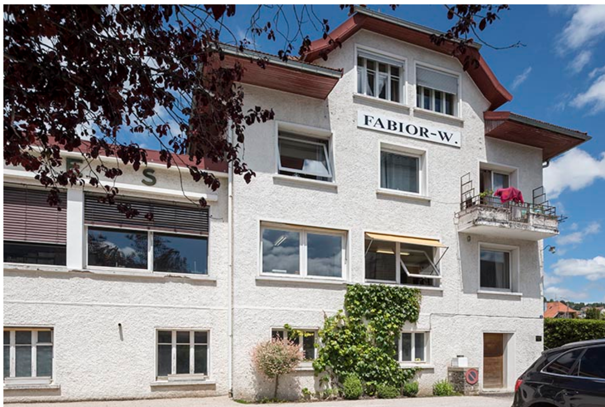
Façade antérieure de la maison.
