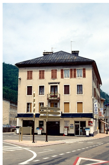
Façade antérieure. Phot. Laurent Poupard
