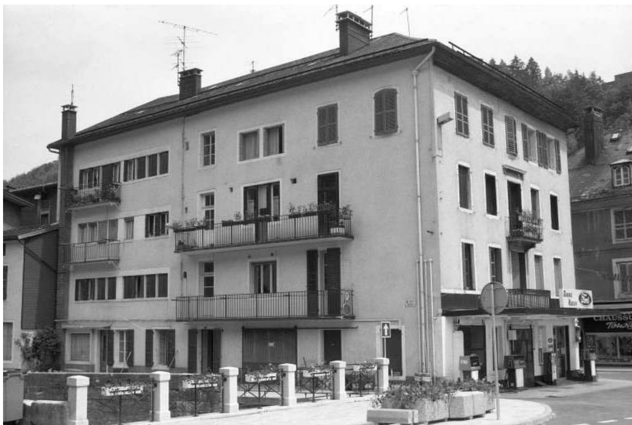
Façades antérieure et latérale gauche.
