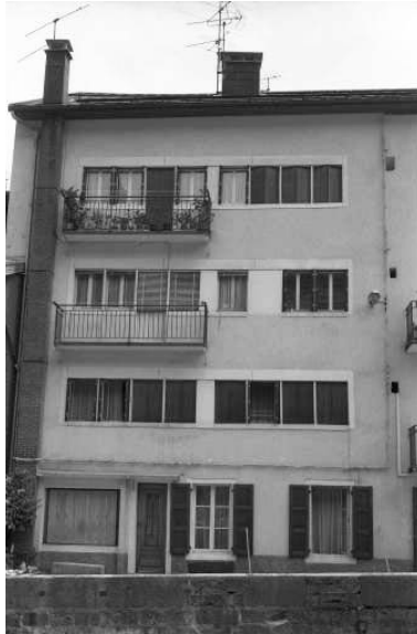
Détail de la façade latérale gauche. Phot. Laurent Poupard IVR43_19913901435Z
