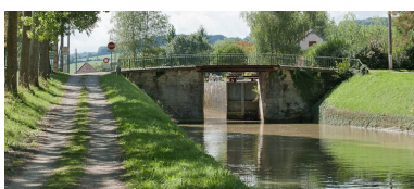
Vue du pont depuis l'aval.
