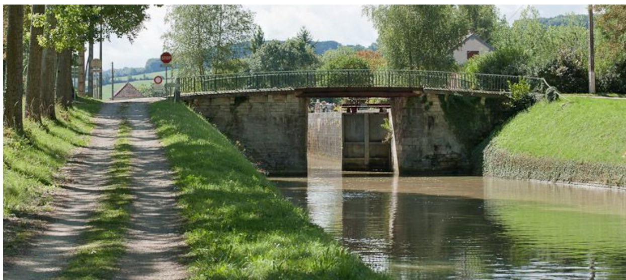
Vue du pont depuis l'aval.
