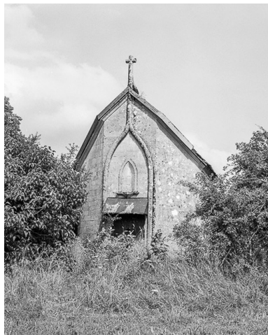
Façade antérieure. Phot. Dominique Dominguez IVR43_19792500941X
