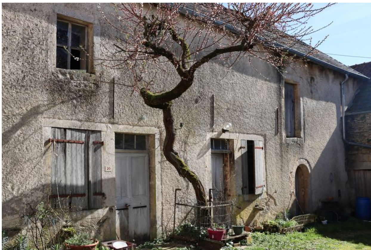
Vue de l'élévation Ouest du logis depuis la cour de la ferme.
