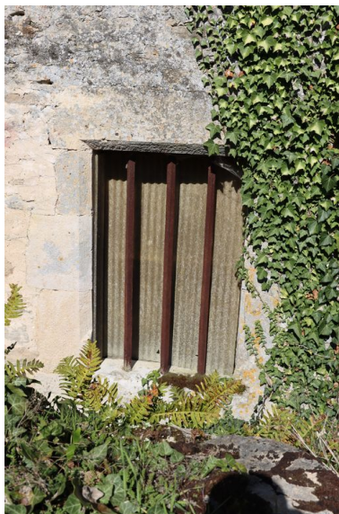
Détail d'une fenêtre de l'extension sud. Phot. Baptiste Quost IVR26_20242100014NUC2A
