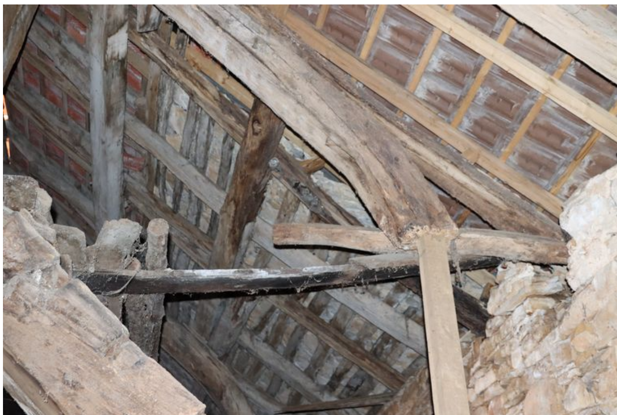
Vue de la sous-face du toit en laves de la maison.
