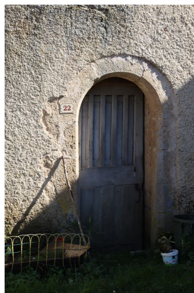
Vue de la porte de l'élévation Ouest ouvrant sur la partie sud du logis.
