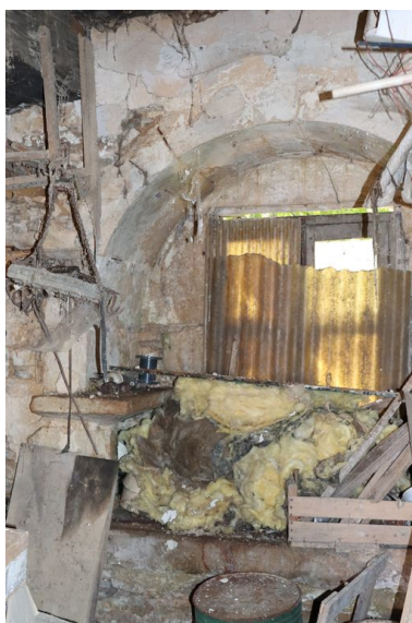
Vue de la niche (placard et évier) aménagée dans le mur gouttereau Est. Phot. Baptiste Quost IVR26_20242100017NUC2A
