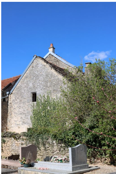
Vue du mur pignon de l'extension Sud. Phot. Baptiste Quost IVR26_20242100013NUC2A
