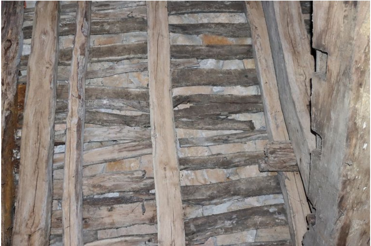
Détail de la sous-face du toit en lave de la maison.
