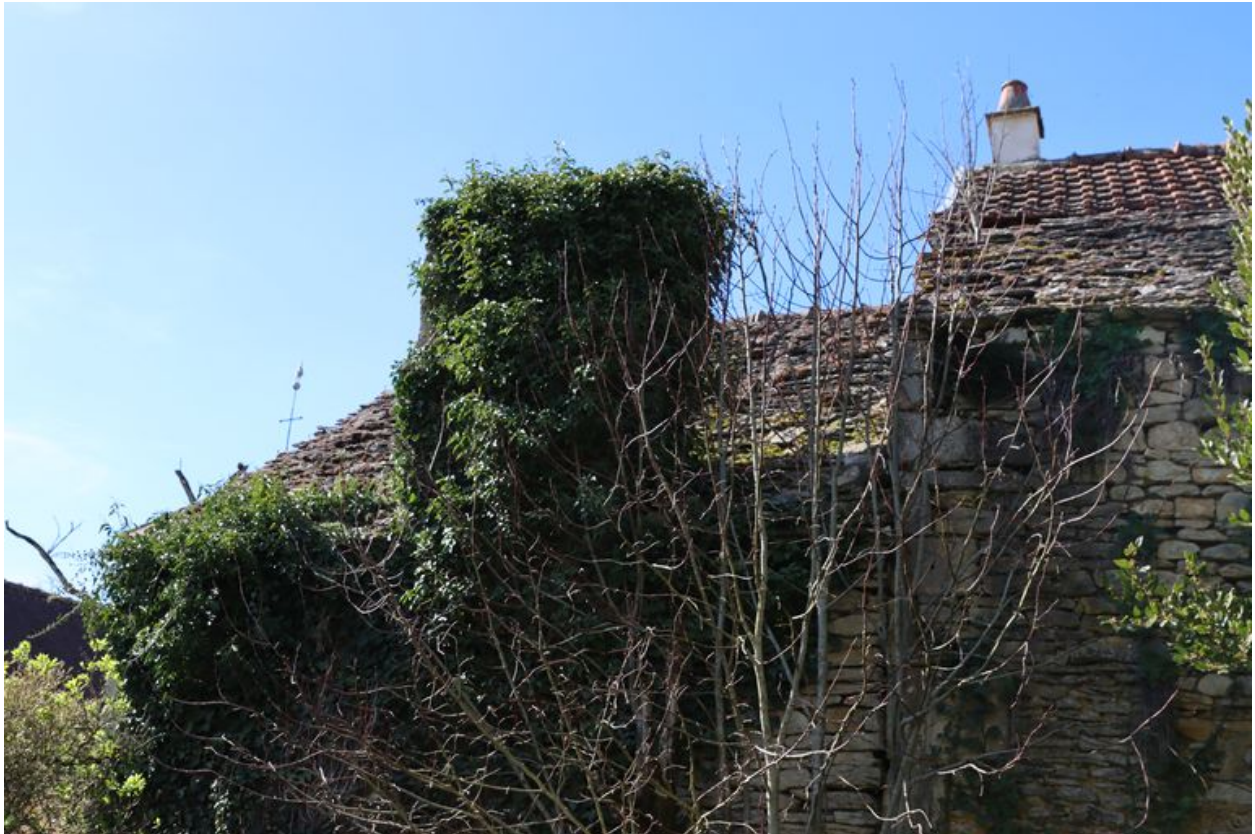
Vue du toit de l'extension Sud, couvert en partie en laves.
