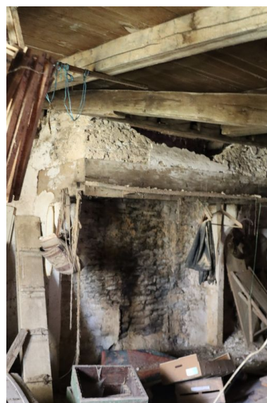
Vue de la cheminée de l'étage de la maison.
