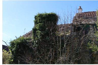
IVR26_20242100008NUC2A Vue du toit de l'extension Sud, couvert en partie en laves. Phot. Baptiste Quost IVR26_20242100012NUC2A
