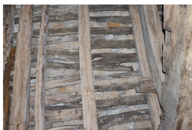
Détail de la sous-face du toit en laves de la maison. Phot. Baptiste Quost IVR26_20242100016NUC2A
