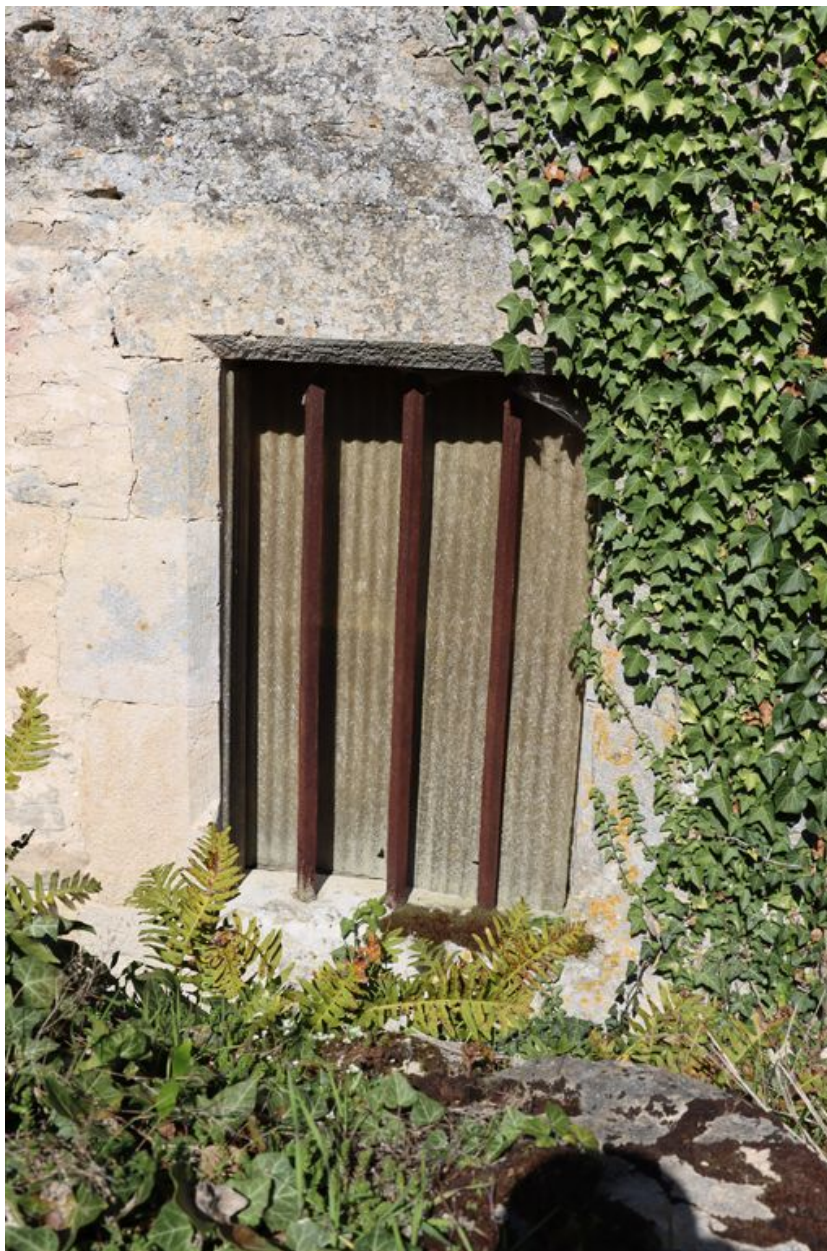
Détail d'une fenêtre de l'extension sud.
