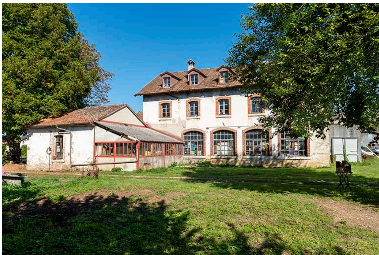
Usine d'outillage (la "Fabrique"), 31-33 rue de Saint-Hippolyte.
