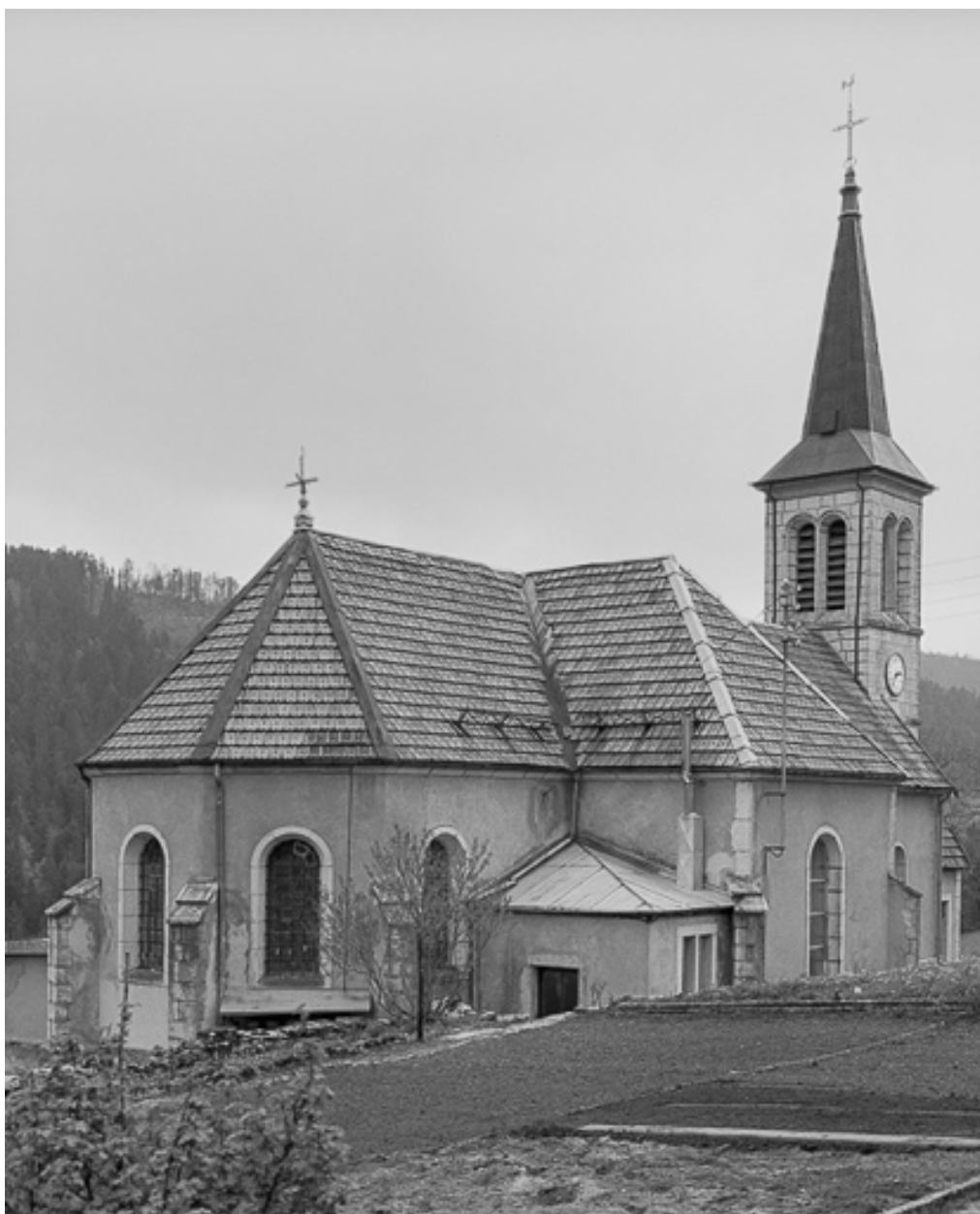
Façades postérieure et face latérale gauche.
