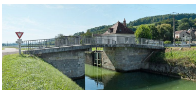
Vue du pont depuis l'aval. Phot. Pierre-Marie Barbe-Richaud
