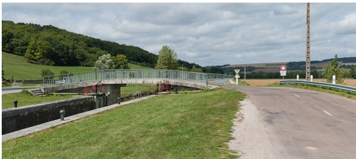
Vue du pont depuis l'amont.
