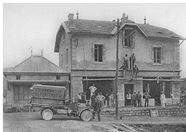
La Fraternelle, Société coopérative d'alimentation ; succursale de Chassal - Immeuble en construction. Phot. IVR43_19923900252X
