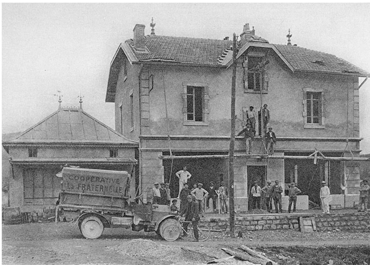
La Fraternelle, Société coopérative d'alimentation ; succursale de Chassal - Immeuble en construction.
