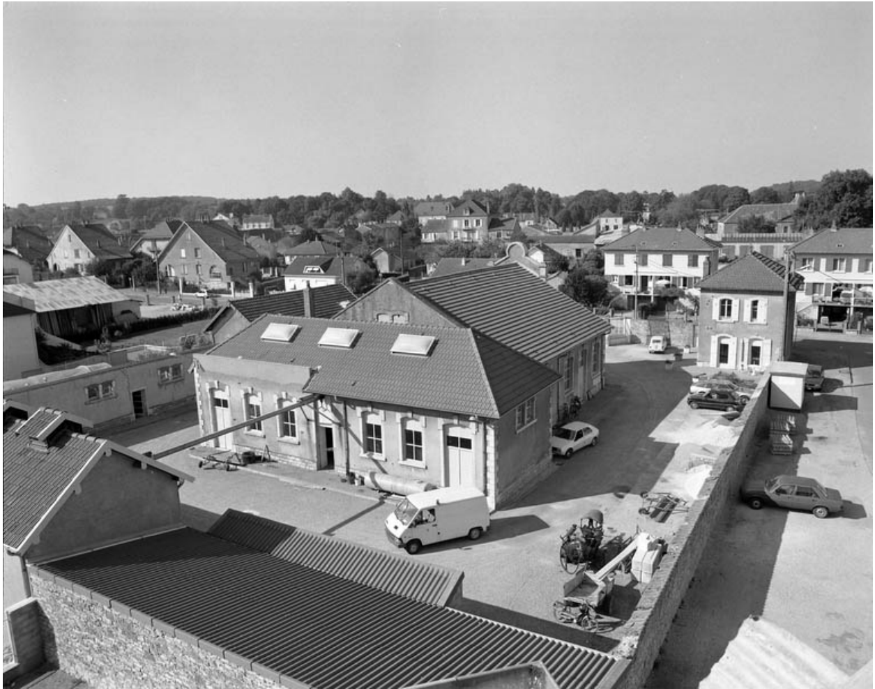
Vue d'ensemble du quartier de l'abattoir.
