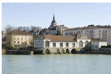
moulin à farine dit moulin Tramoy, puis minoterie des Grands Moulins de Gray, actuellement centrale hydroélectrique : vue d'ensemble depuis le nord-ouest. Phot. Jérôme Mongreville IVR43_20097000192NUC2A
