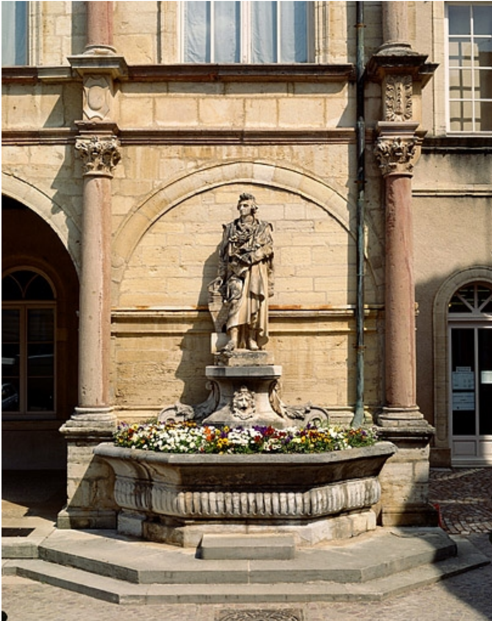
Fontaine de Romé de l'Isle : vue d'ensemble.
