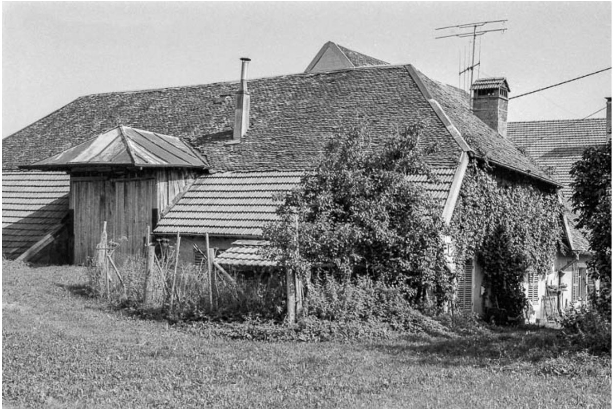
Ferme cadastrée 1961 AB 62 : façade latérale gauche.
