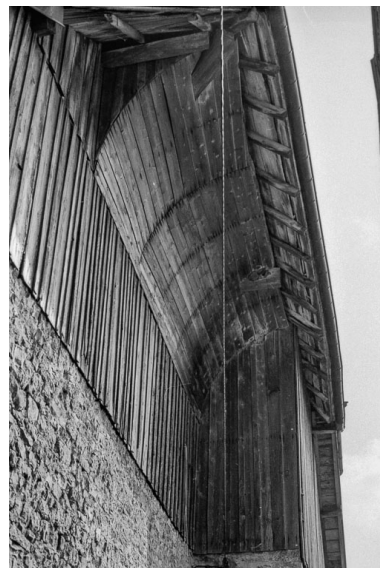
Ferme cadastrée 1961 AB 50 : bardage. Phot. Gilbert Poinot IVR43_19752501342Z
