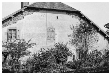
Ferme cadastrée 1961 AC 107 : façade antérieure. Phot. Gilbert Poinot
