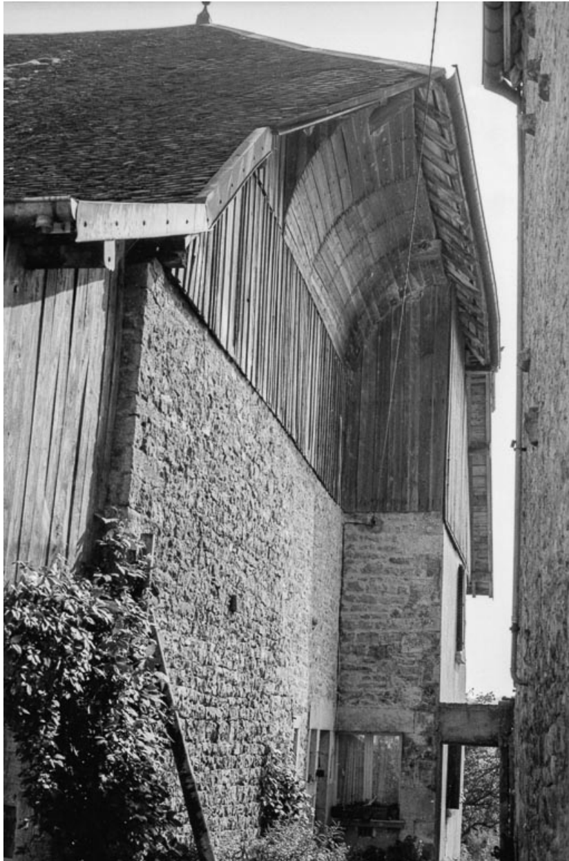
Ferme cadastrée 1961 AB 50 : façade postérieure (?).
