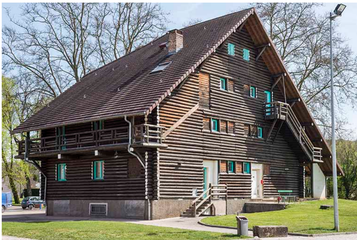
Détail sur les façades nord et ouest.
