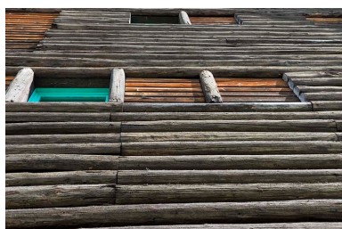
Le mur recouvert de demi-rondins de sapin. Phot. Jérôme Mongreville IVR43_20177000666NUC4A
