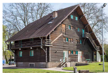
Détail sur les façades nord et ouest. Phot. Jérôme Mongreville IVR43_20177000665NUC4A
