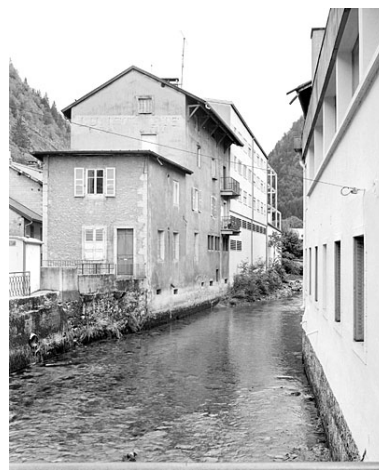
Vue d'ensemble depuis le nord- ouest : façades sur Bienne. Phot. Yves Sancey IVR43_20033900493X
