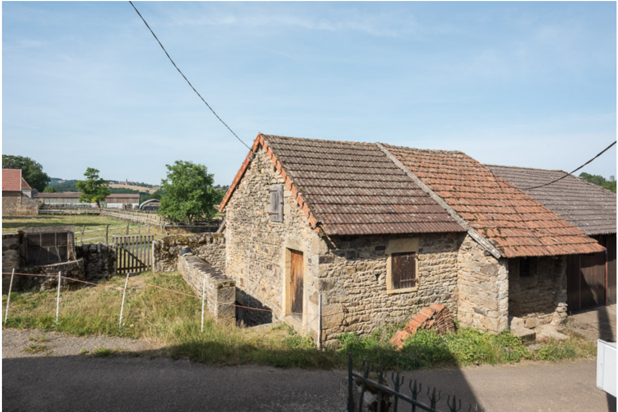
Vue d'un bâtiment dépendant de la ferme n°4 (A 379), de l'autre côté du chemin, abritant une cave et un four à pain.
