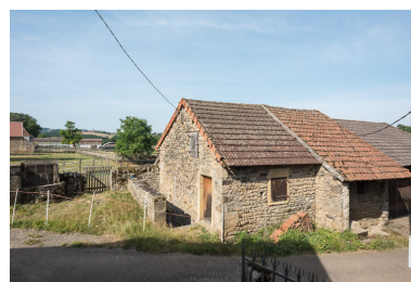
Vue d'un bâtiment dépendant de la ferme n°4 (A 379), de l'autre côté du chemin, abritant une cave et un four à pain. Phot. Pierre-Marie Barbe-Richaud IVR26_20197100215NUC4A
