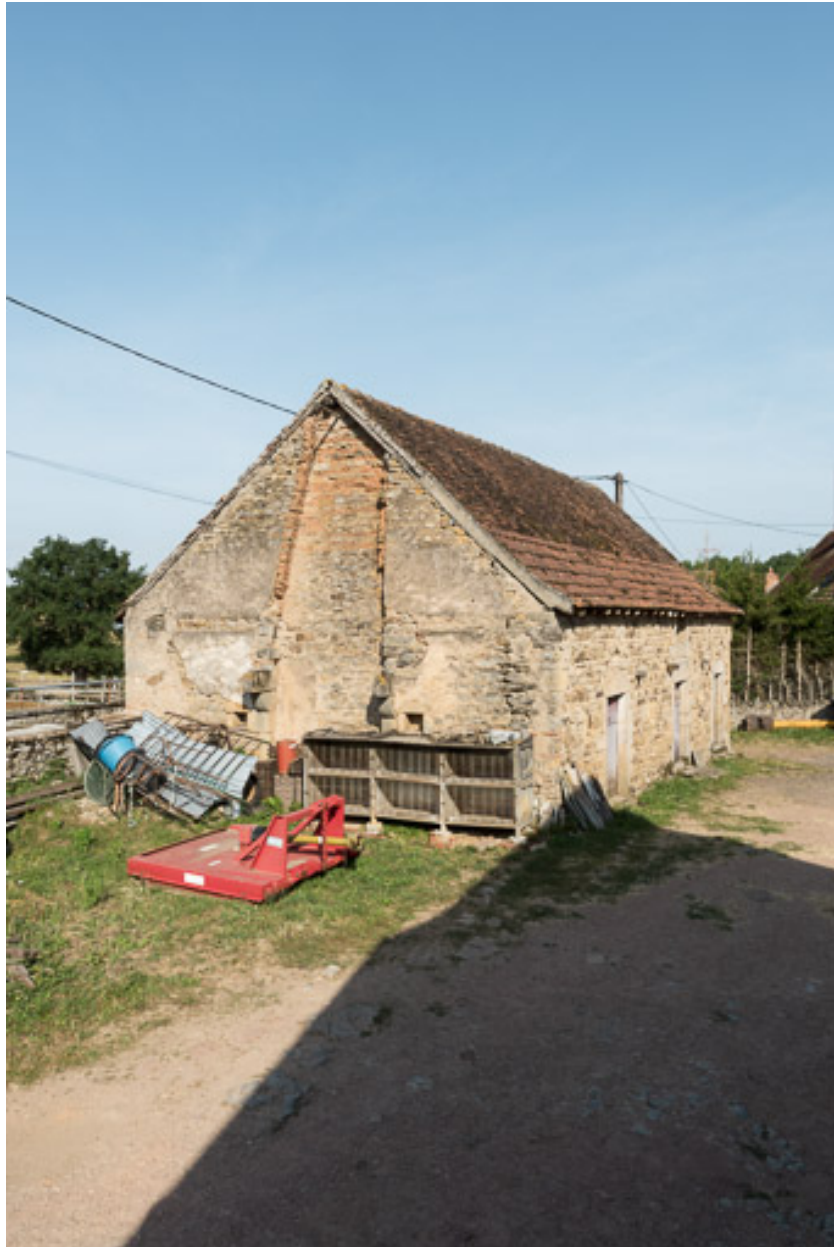
Vue du mur-pignon est de la dépendance, qui conserve une trace de la cheminée de la maison de la ferme n°2 (A 381).
