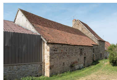
Vue postérieure de l'alignement. le hangar, à gauche, a été construit à l'emplacement de la maison de la ferme n°1 (A 382). Phot. Pierre-Marie Barbe-Richaud IVR26_20197100218NUC4A
