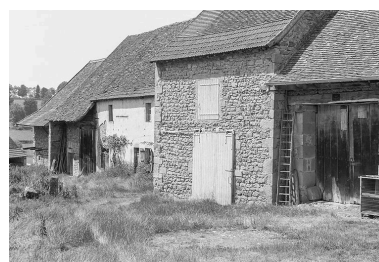
Vue des bâtiments, constituant la seconde partie de l'alignement, vers 1970. Phot. Raymond Oursel IVR26_20207100075NUC2
