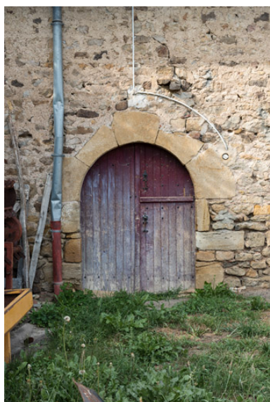
Porte de l'étable de la grange de la ferme n°4, couverte d'un arc en plein cintre. Phot. Pierre-Marie Barbe-Richaud IVR26_20197100173NUC4A
