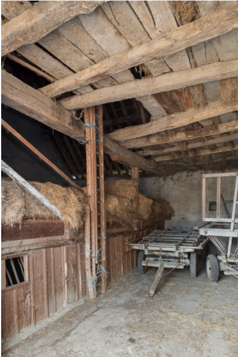
Vue intérieure de la grange de la ferme n°4 (A 379).
