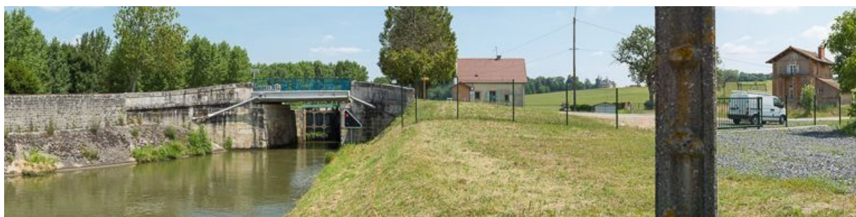
Le pont, vu d'aval.
