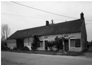
Vue d'ensemble d'une ferme (cad. 1984, sect. B, parc. 48).
