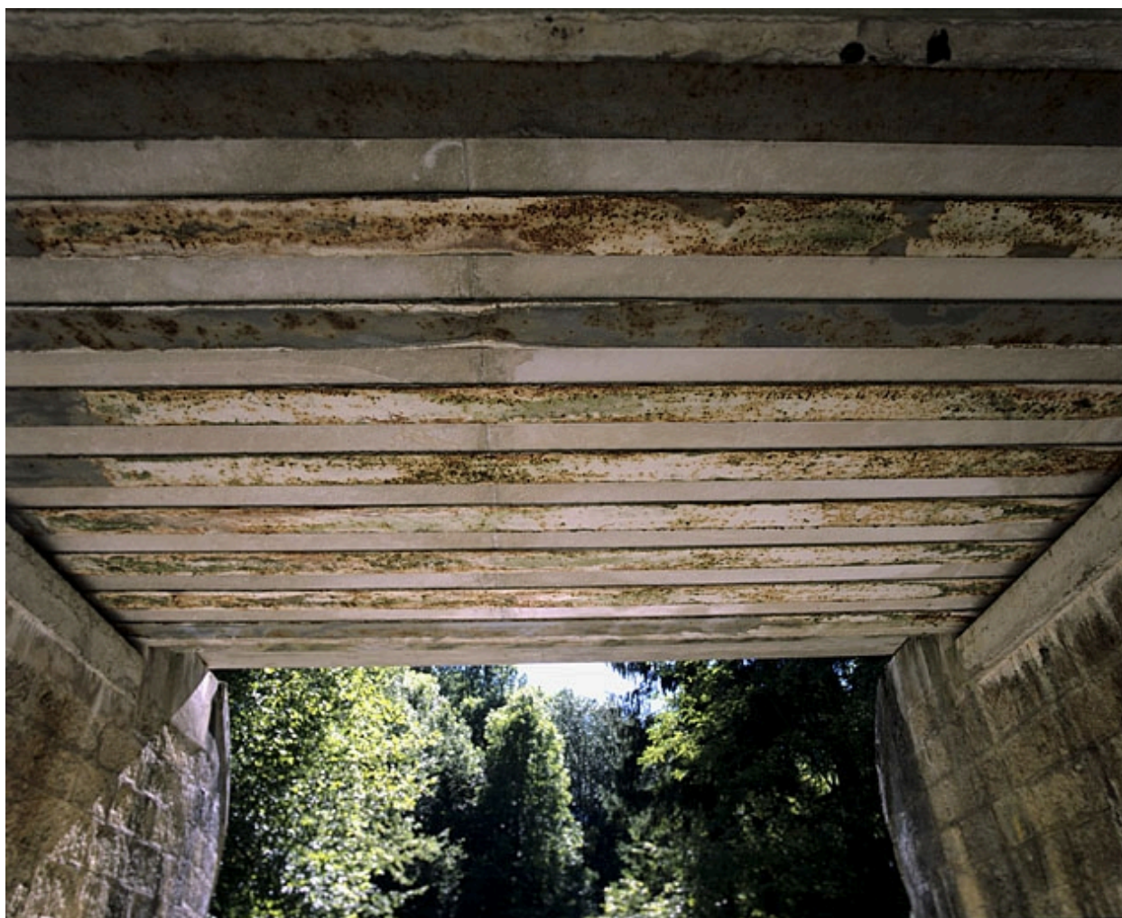
Pont : poutrelles en face inférieure du tablier.
