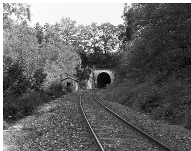
Tunnel d'Arpent 2 : vue d'ensemble de la tête côté Andelot-en-Montagne (ouest). Phot. Yves Sancey IVR43_20050100061X
