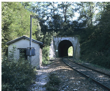
Tunnel d'Arpent 2 : tête côté Andelot-en-Montagne (ouest). Phot. Yves Sancey IVR43_20050100063XA
