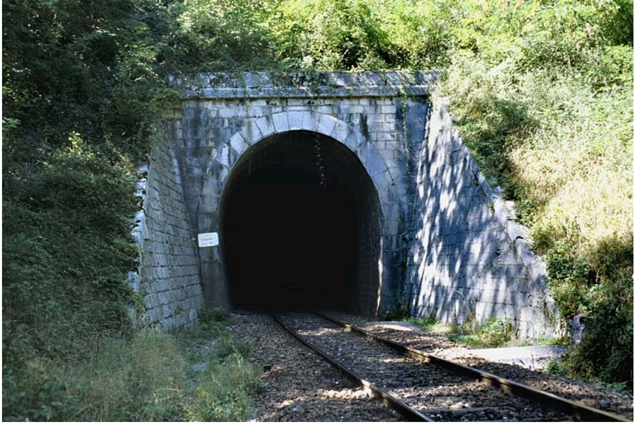
Tunnel d'Arbent 1 : tête côté La Cluse (sud-est).
