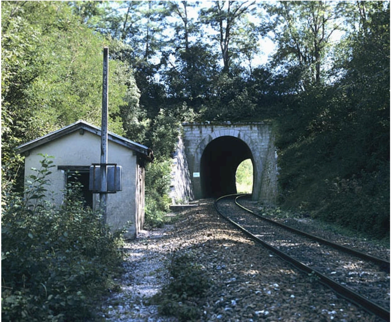
Tunnel d'Arbent 2 : tête côté Andelot-en-Montagne (ouest).
