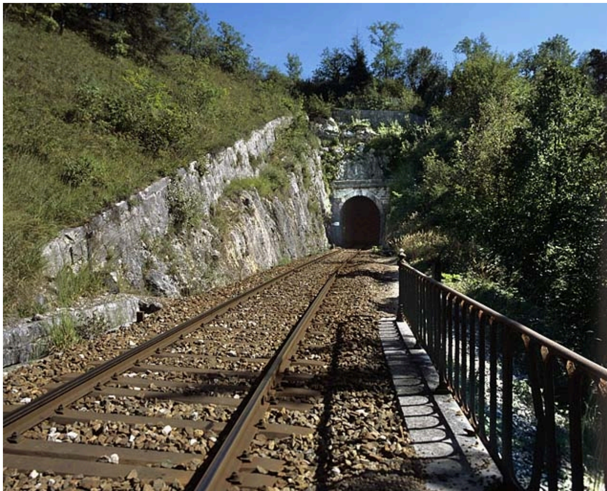
Tunnel d'Arbent 1 : vue d'ensemble de la tête côté Andelot-en-Montagne (nord-ouest).
