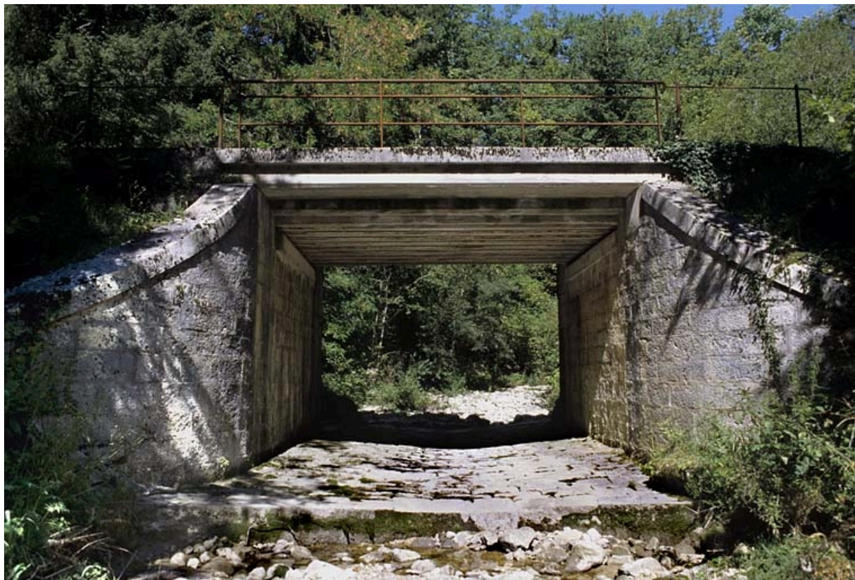
Pont : vue d'ensemble depuis le lit du Merdanson, en aval.
