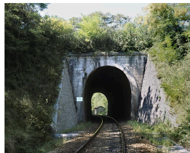
Tunnel d'Arpent 2 : tête côté La Cluse (est). Phot. Yves Sancey IVR43_20050100065XA
