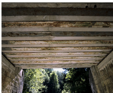
Pont : poutrelles en face inférieure du tablier. Phot. Yves Sancey IVR43_20050100060XA
