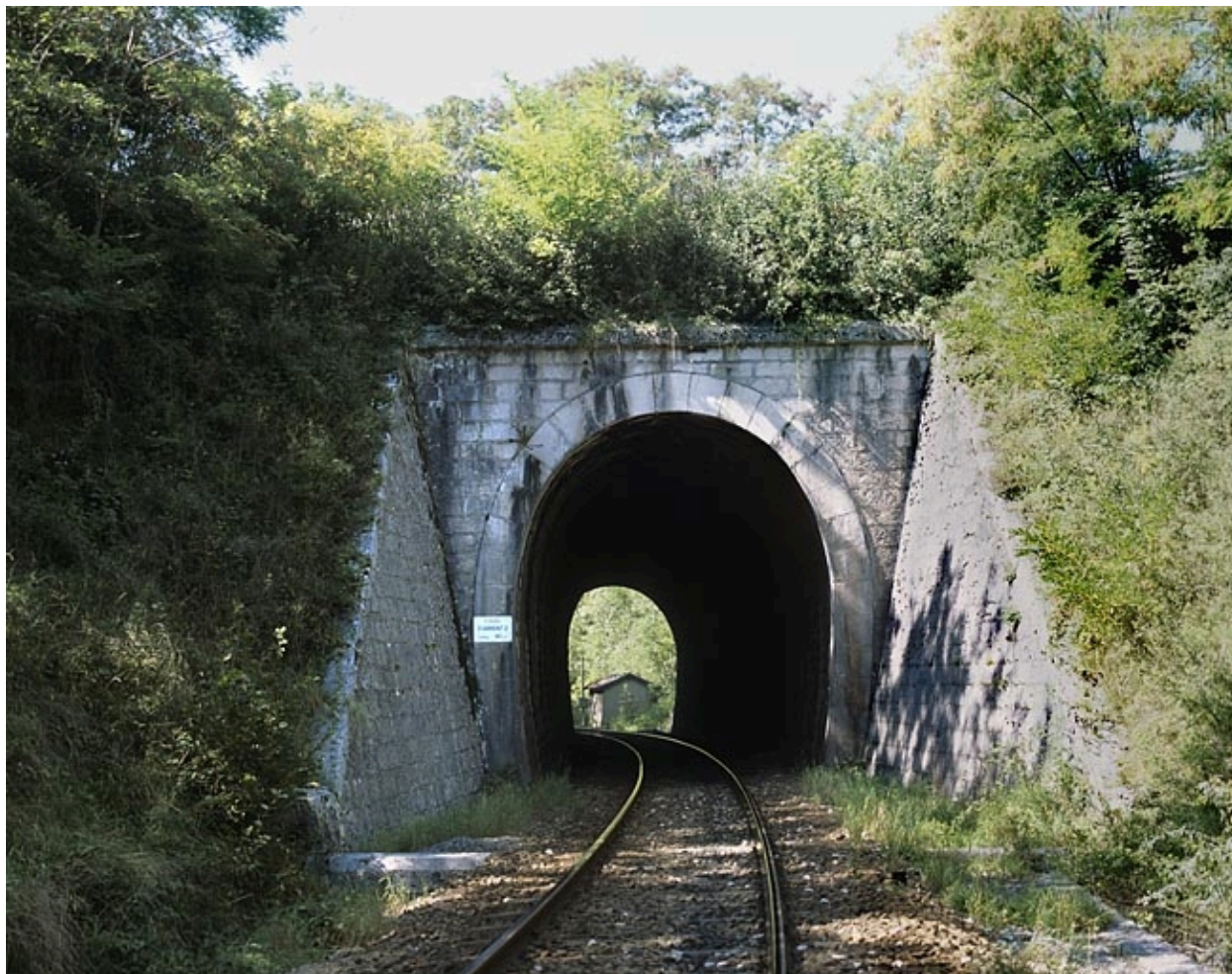
Tunnel d'Arbent 2 : tête côté La Cluse (est).
