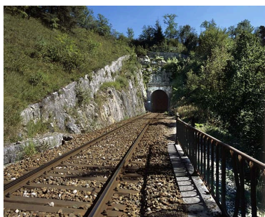
Tunnel d'Ardent 1 : vue d'ensemble de la tête côté Andelot-en-Montagne (nord-ouest).
