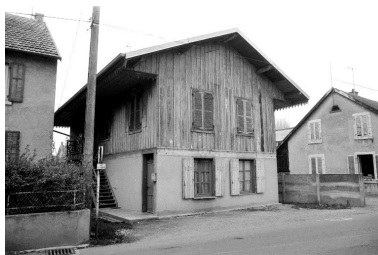
Vue de trois quarts gauche. Phot. Bernard Lardière IVR43_19832500219Z
