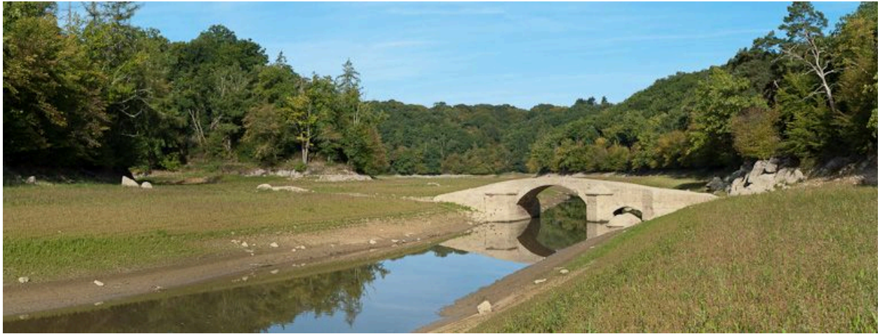
Vue du pont.
