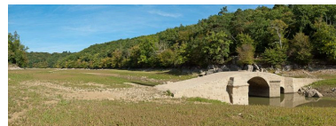
Vue du pont.
