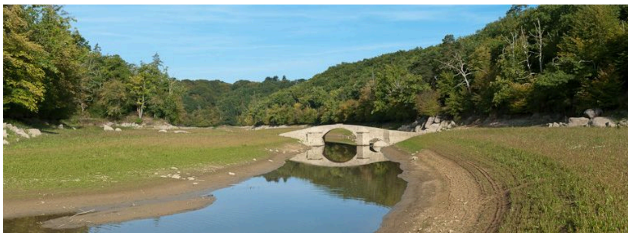
Vue du pont.
