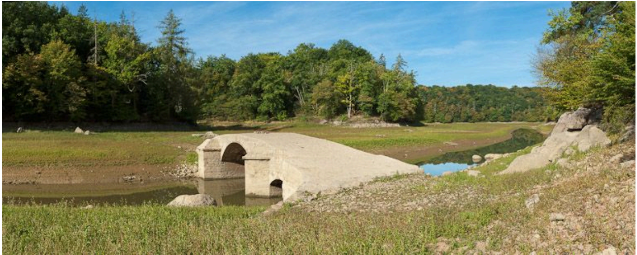
Vue du pont.
