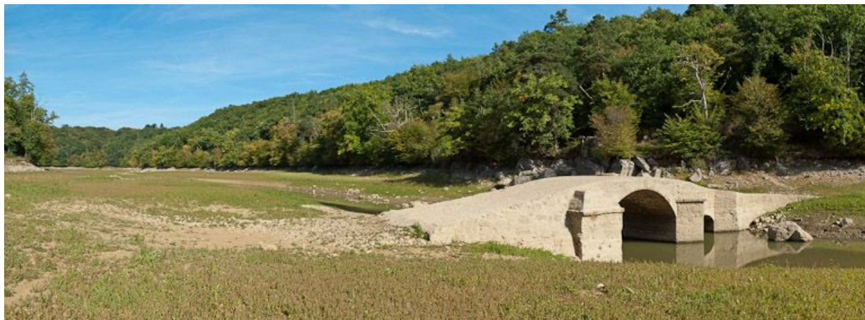
Vue du pont.
