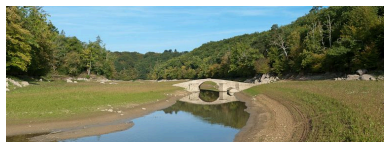
Vue du pont.
