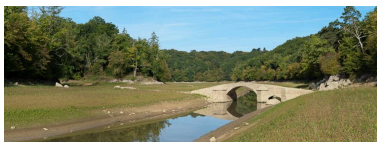
Vue du pont.
