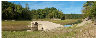
Vue du pont.
