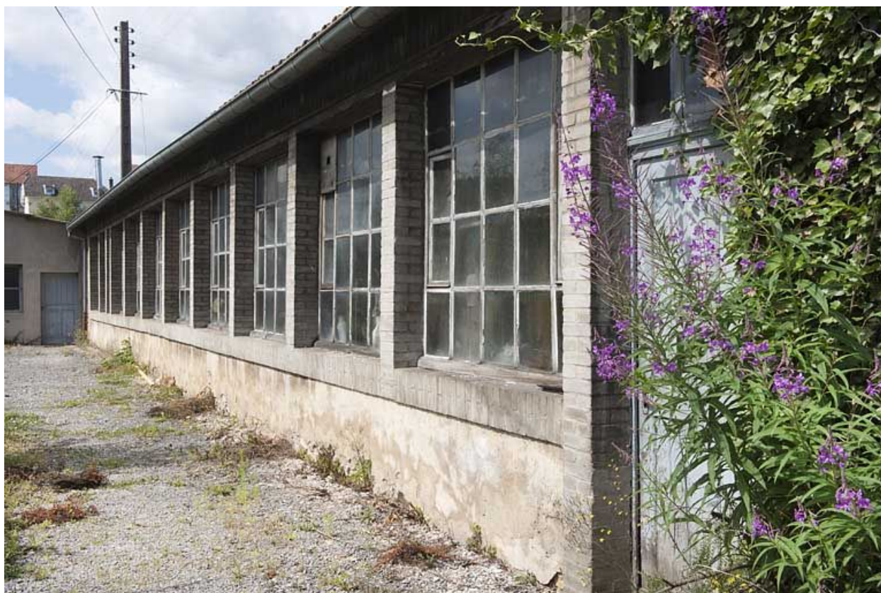
Façade est de l'atelier de décolletage primitif.
