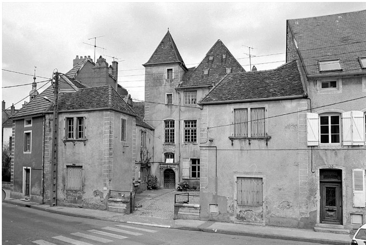
Vue d'ensemble depuis la rue.
