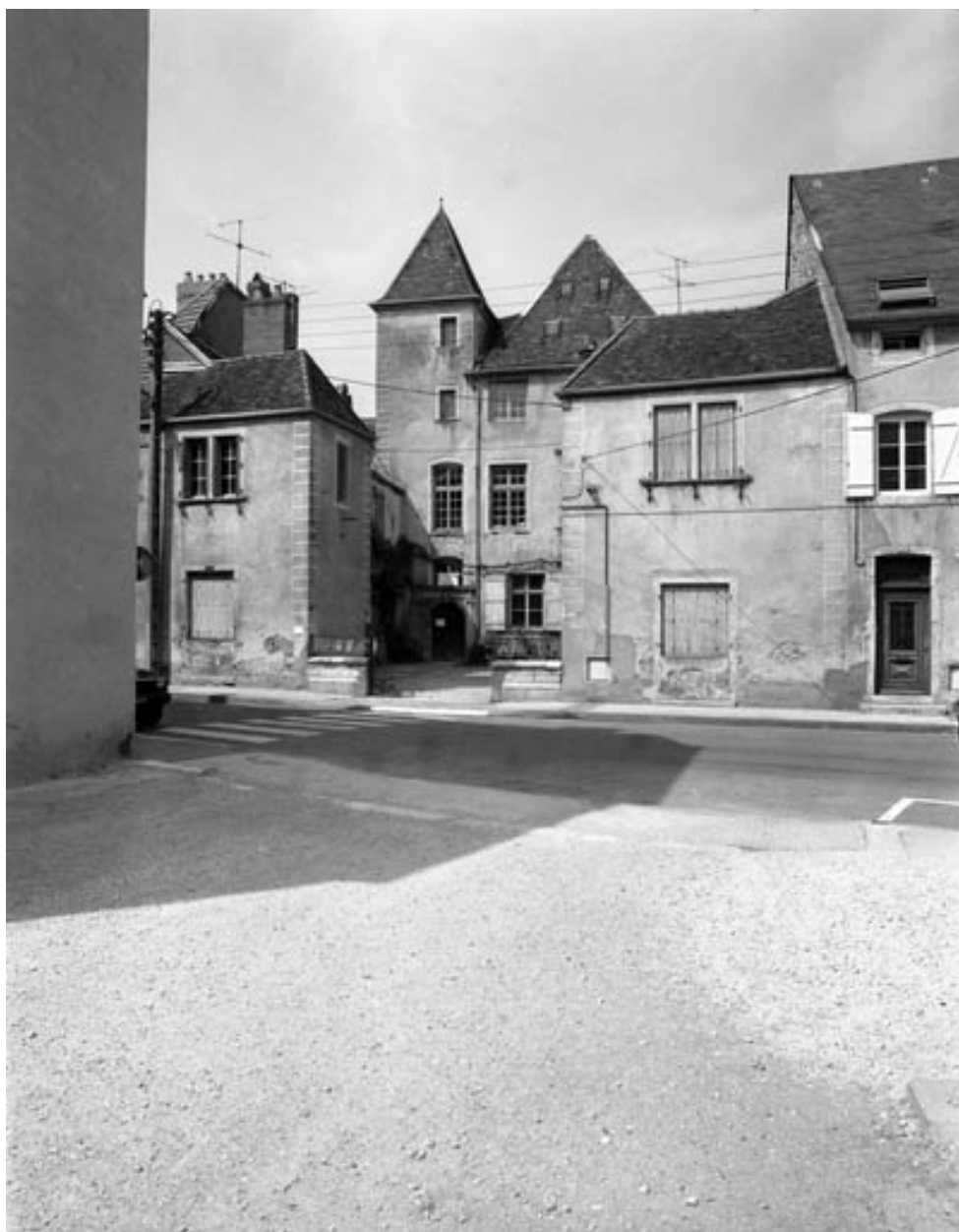
Vue d'ensemble depuis la rue.
