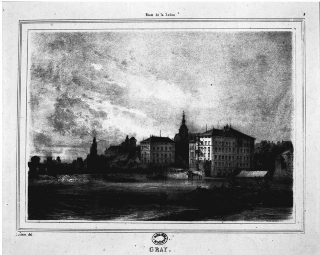
Rives de la Saône [vue d'ensemble depuis la rive droite].
