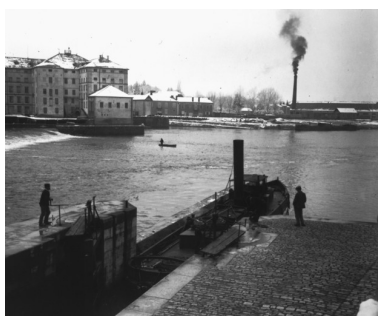
Les Grands Moulins de Gray vus depuis l'écluse. Phot. Yves Sancey IVR43_19857000119V
