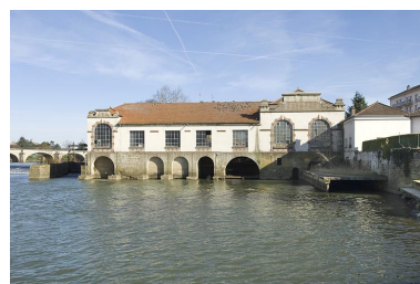
Soubassement de la minoterie et façade ouest de la centrale hydroélectrique. Phot. Jérôme Mongreville IVR43_20097000193NUC2A
