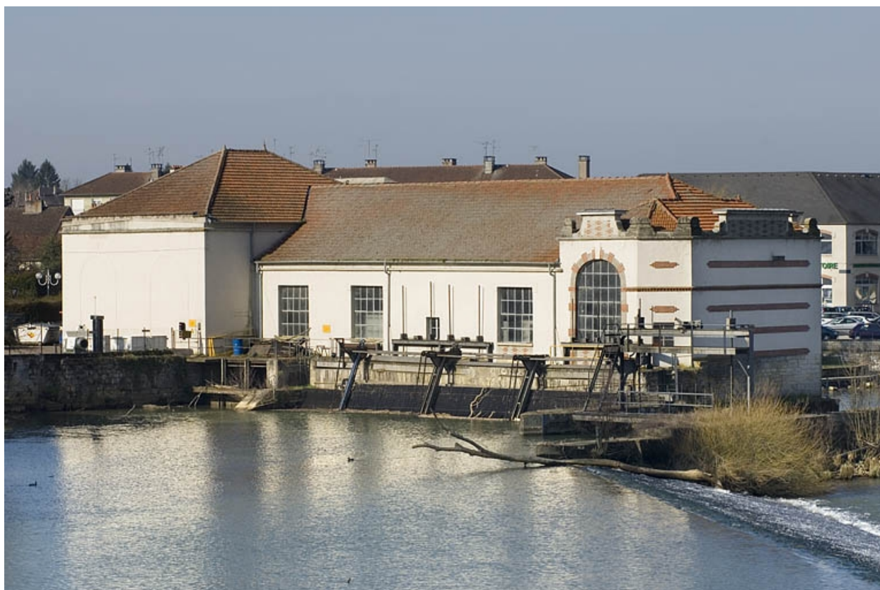
La centrale hydroélectrique vue de trois quarts.
