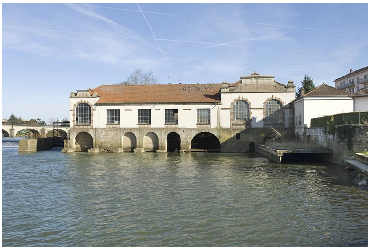
Soubassement de la minoterie et façade ouest de la centrale hydroélectrique.
