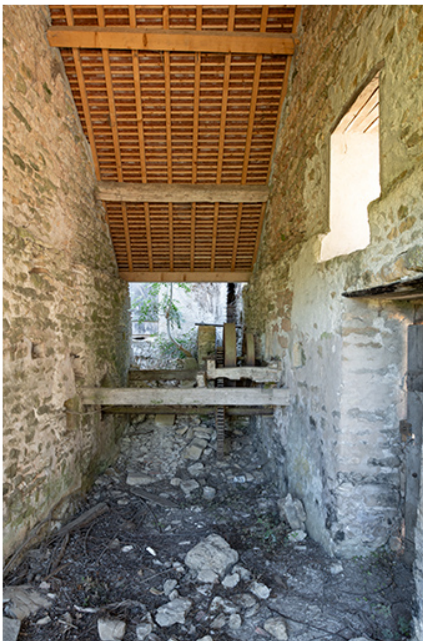
L'intérieur du bâtiment abritant le mécanisme.
