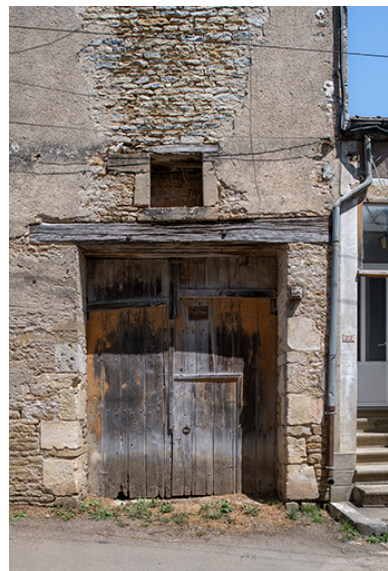
Entrée de la grange. Phot. Nicolas Waltefaugle IVR26_20268900290NUC4A
