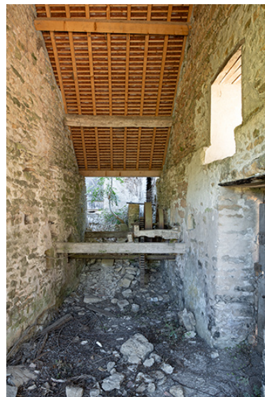
L'intérieur du bâtiment abritant le mécanisme. Phot. Nicolas Waltefaugle IVR26_20268900292NUC4A
