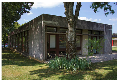
Angle sud-ouest de l'administration. Phot. Sonia Dourlot IVR43_20142500932NUC2A
