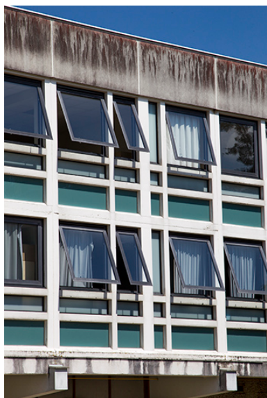
Détail de façade postérieure - ouest - de l'externat. Phot. Sonia Dourlot IVR43_20142500938NUC2A
