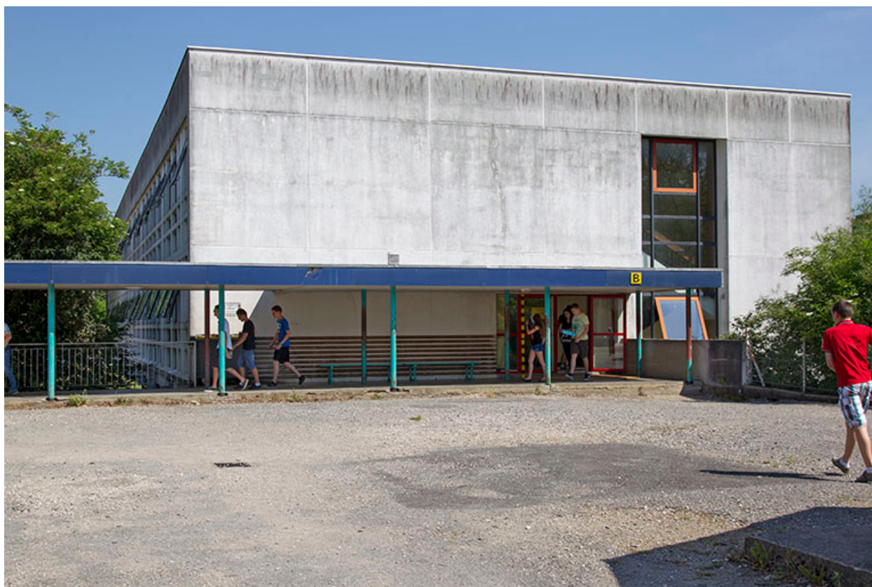
Pignon sud de l'externat.
