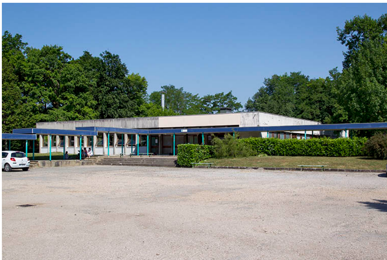
Façade sud de la cantine.
