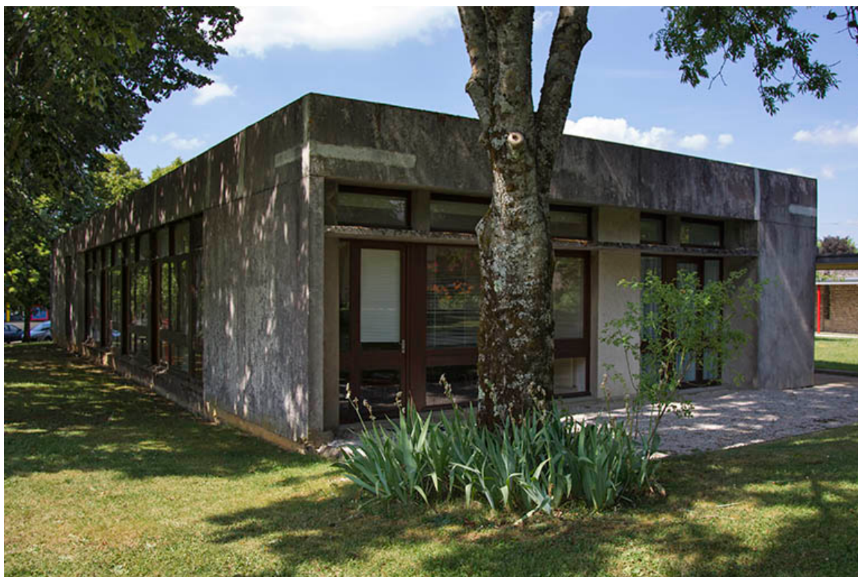
Angle sud-ouest de l'administration.
