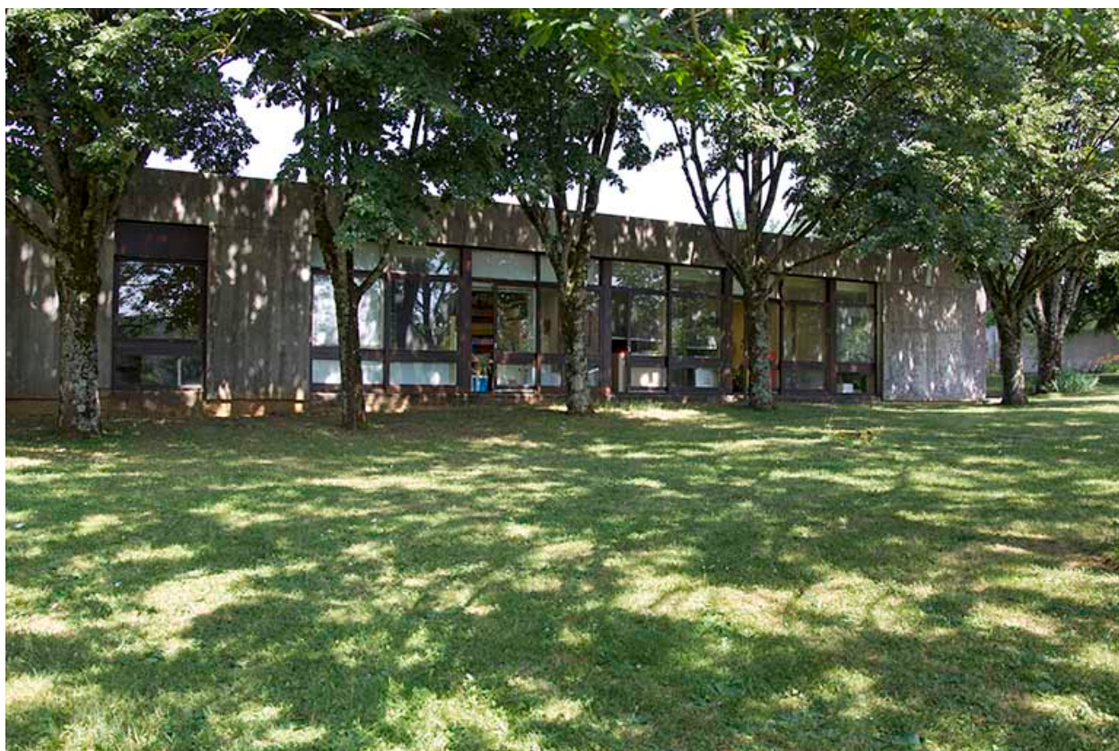
Façade postérieure - ouest - de l'administration.
