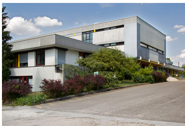
Façade sud et angle sud- ouest du bâtiment d'internat de garçons et d'externat. Phot. Sonia Dourlot IVR43_20142500920NUC2A
