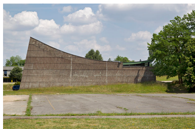
Flanc ouest du gymnase. Phot. Sonia Dourlot IVR43_20142500970NUC2A
