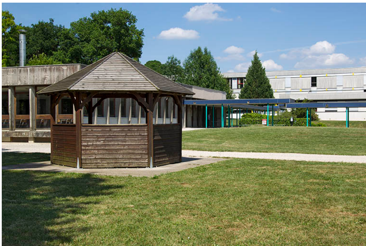
Kiosque à l'angle sud-ouest de la cantine.
