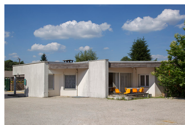
Façade postérieure ouest de la loge. Phot. Sonia Dourlot IVR43_20142500927NUC2A
