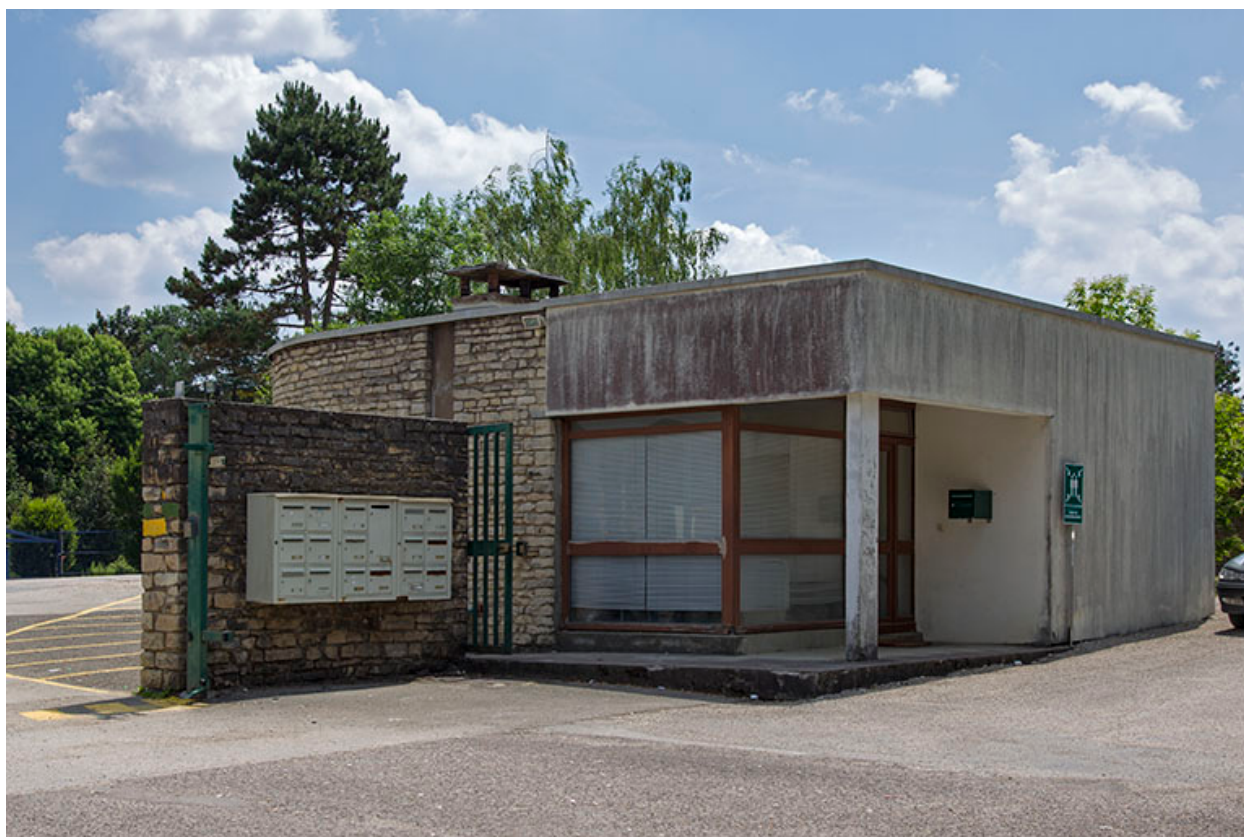
Loge d'entrée vue du nord-ouest.
