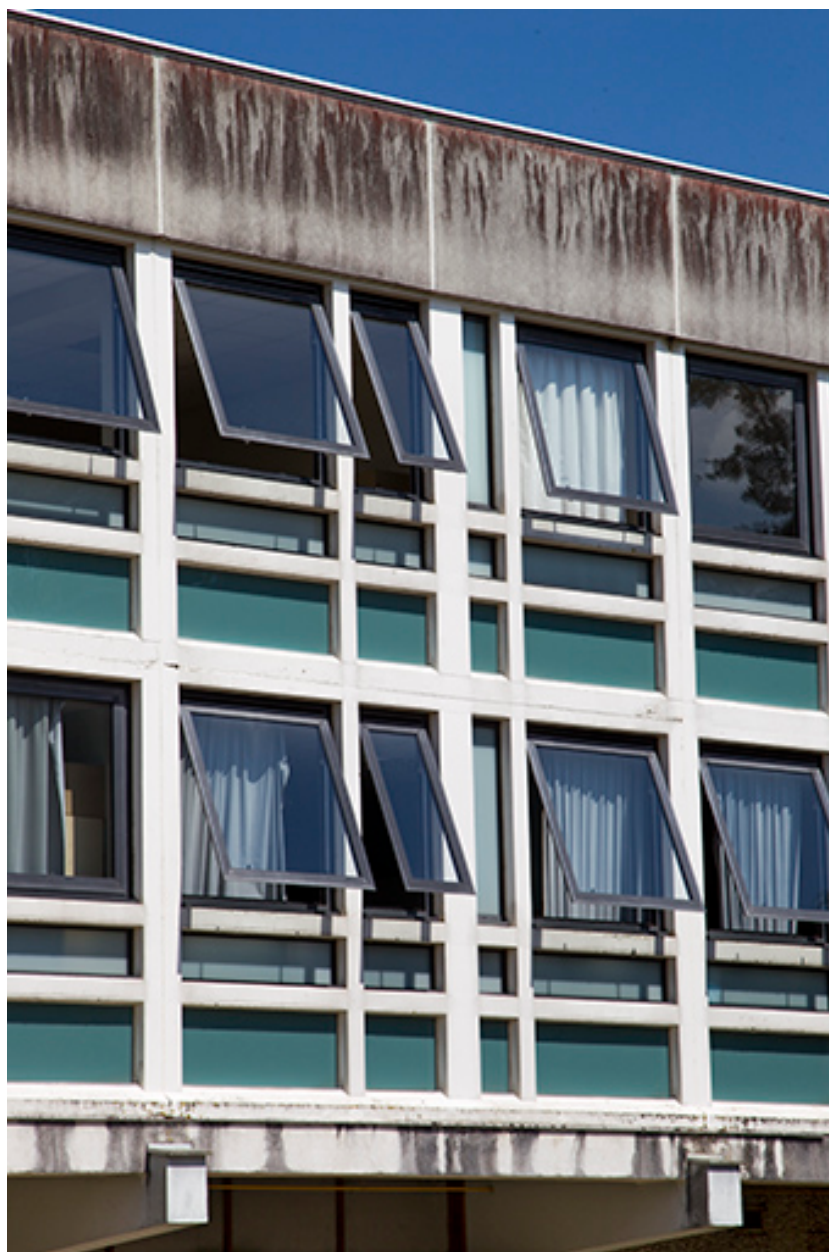
Détail de façade postérieure - ouest - de l'externat.
